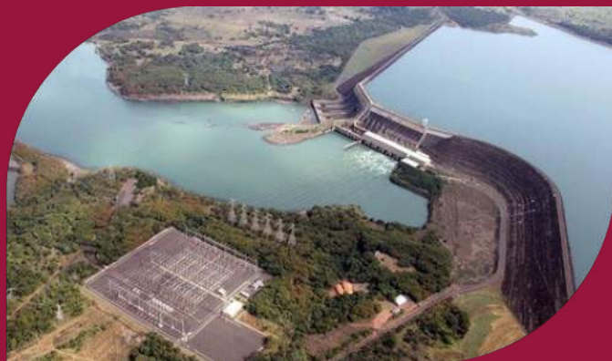
Foto: Usina Hidrelétrica de São Simão fonte: Prefeitura de São Simão (GO)
