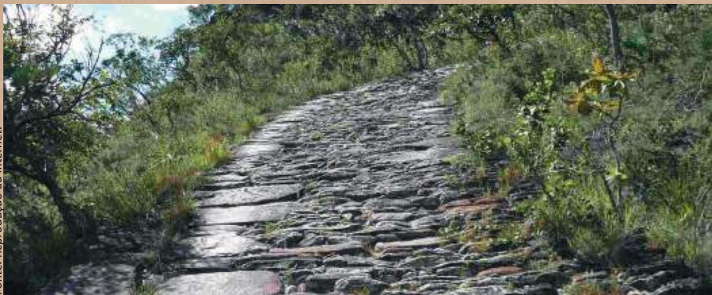
Ao longo do canal os negros levantaram dois aterros para o nivelamento do terreno, um com 500 metros de altura e três metros de profundidade e outro de 1,5 metro de largura e 5 metros de altura. A cada quilômetro de canal, fizeram um declive de 1 metro. Com isso, as águas desviadas do Saia Velha ganhavam força para transpor alguns trechos de subida e circular os morros até chegarem ao destino, a mina de ouro do Cruzeiro, localizada nas adjacências da Igreja do Rosário.
