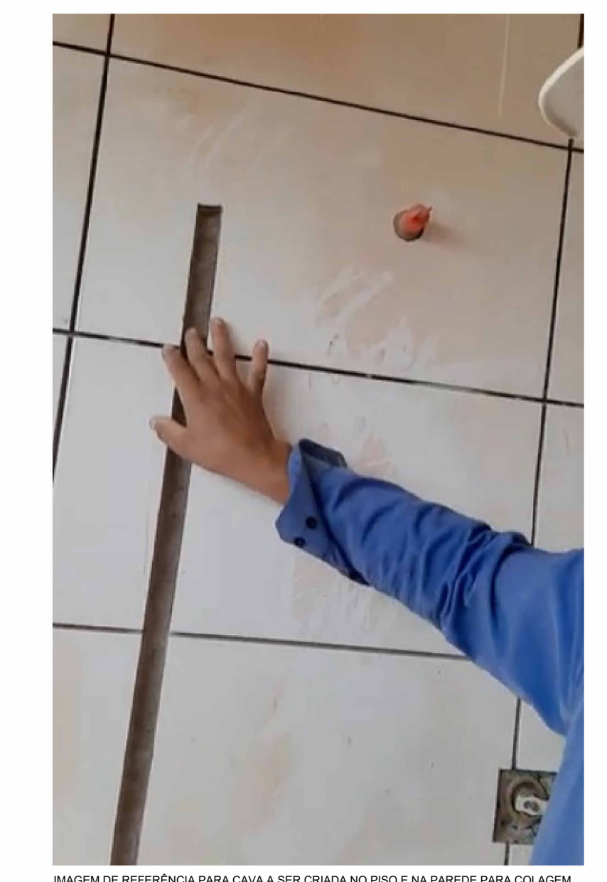
BAIXEM DE REFERÊNCIA PARA CAIXA A 2CM CRADA NO PISO E NA PAREDE PARA COLAGEM DAS DIVISÓRIAS DE GRANITO NOS BOXES.
