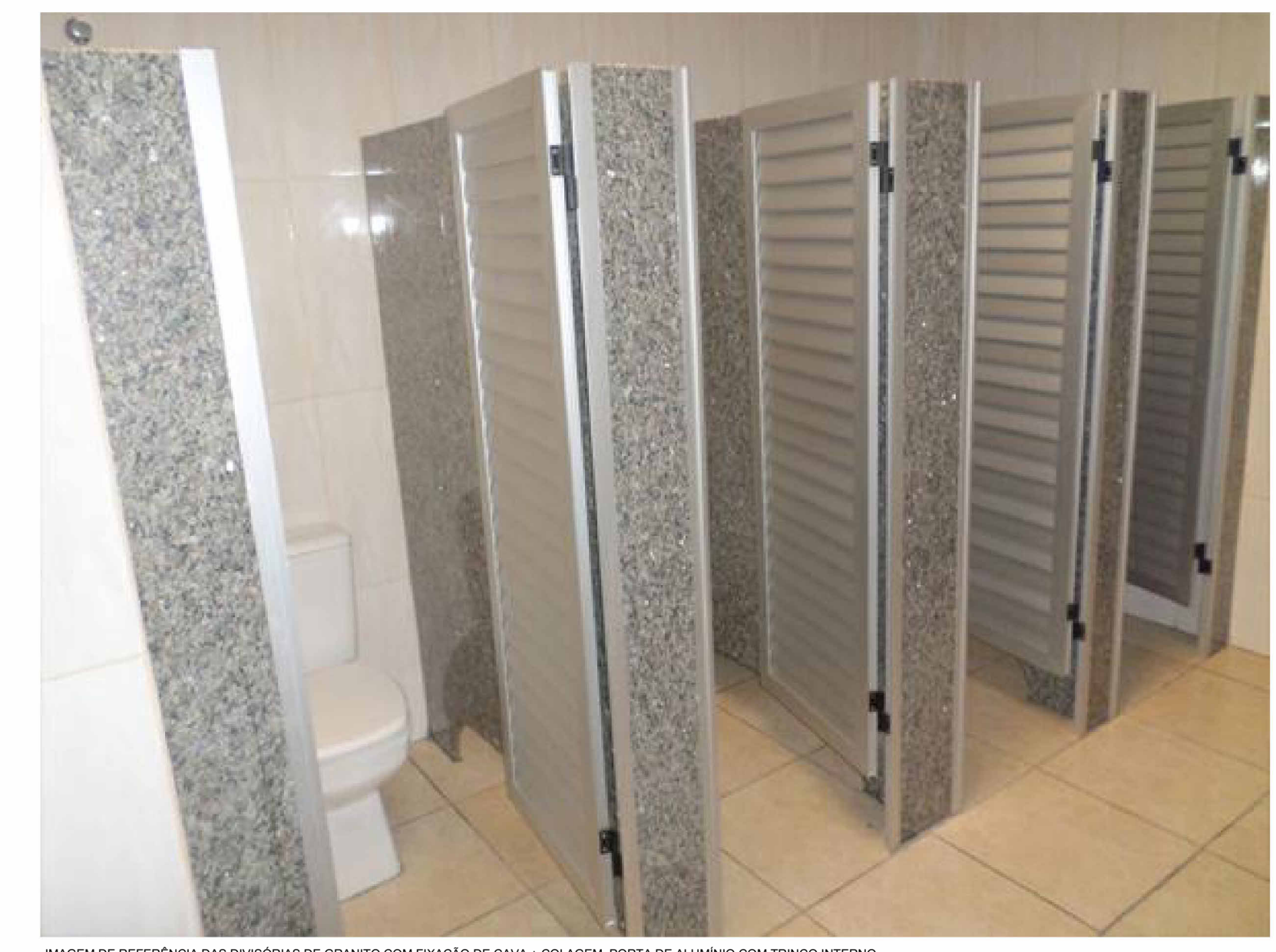
BAIXEM DE REFERÊNCIA DAS DIVISÓRIAS DE GRANITO COM FIXAÇÃO DE CAIXA + COLAGEM. PORTA DE ALUMÍNIO COM TRINCO INTERNO.
