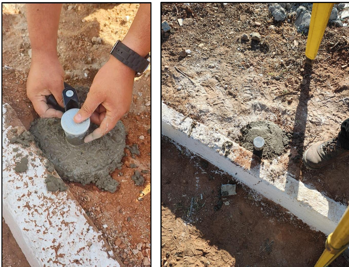
Figura 24: Implantação dos marcos georreferenciados.
