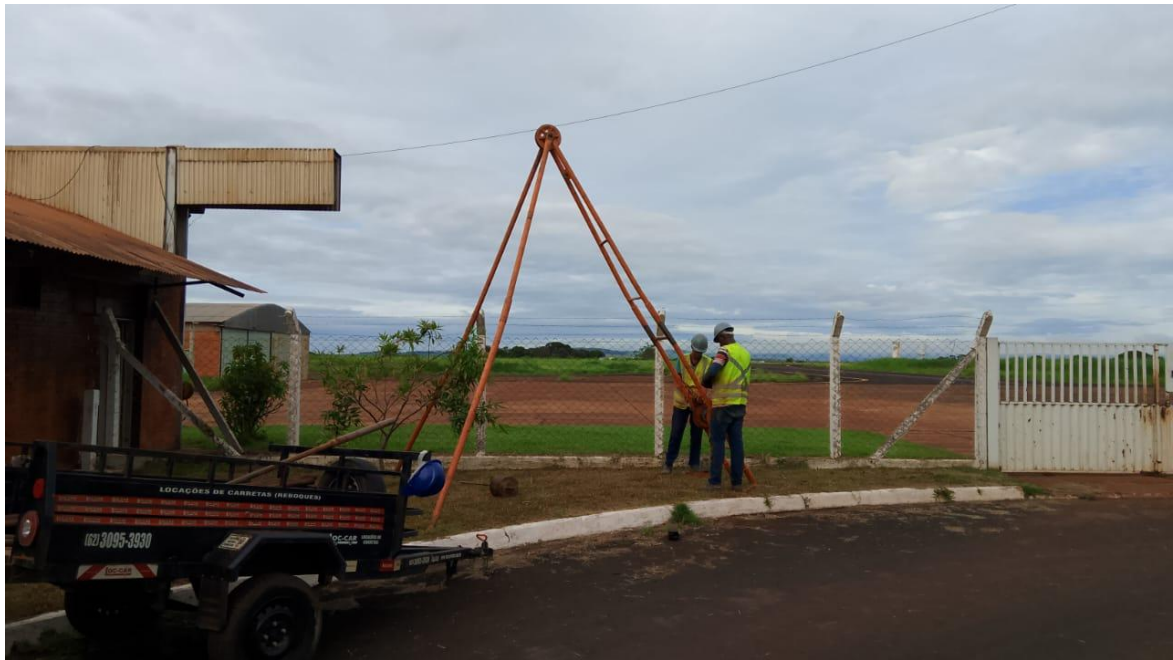
Figura 5 – montagem tripe de sondagem.
