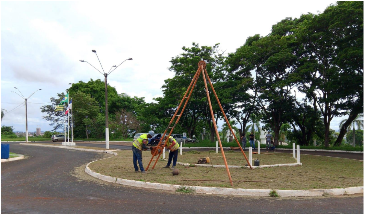
Figura 9 – montagem tripe de sondagem.
