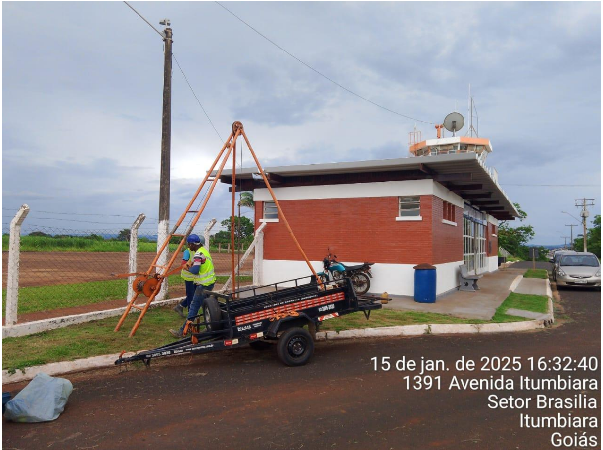
Figura 1 – montagem tripe de sondagem.
