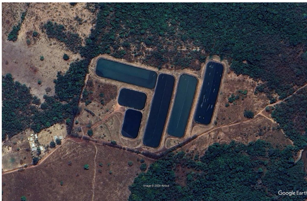
Figura 68 – Imagem aérea do ETE Caiapônia
