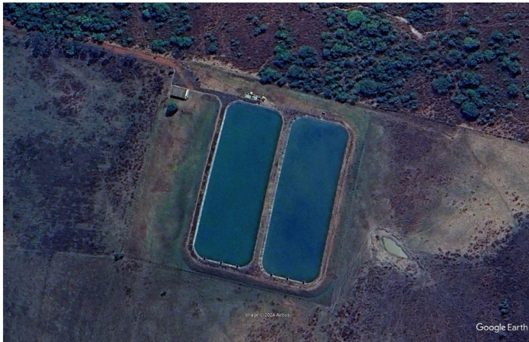
Figura 108 – Imagem aérea do ETE Lagoa Santa
