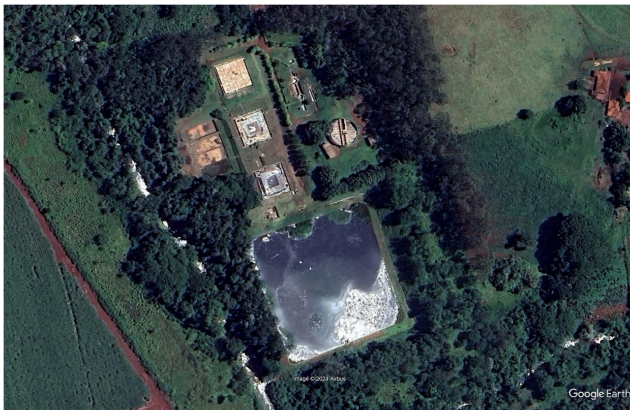
Figura 136 – Imagem aérea da ETE Quirinópolis
