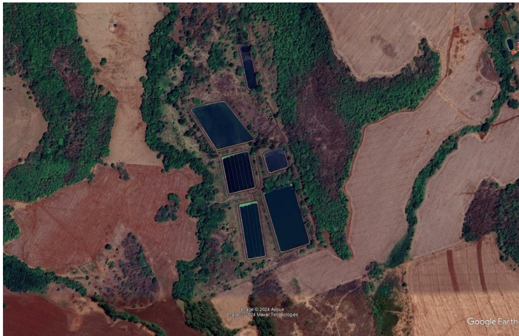
Figura 83 – Imagem aérea da ETE Goiatuba
