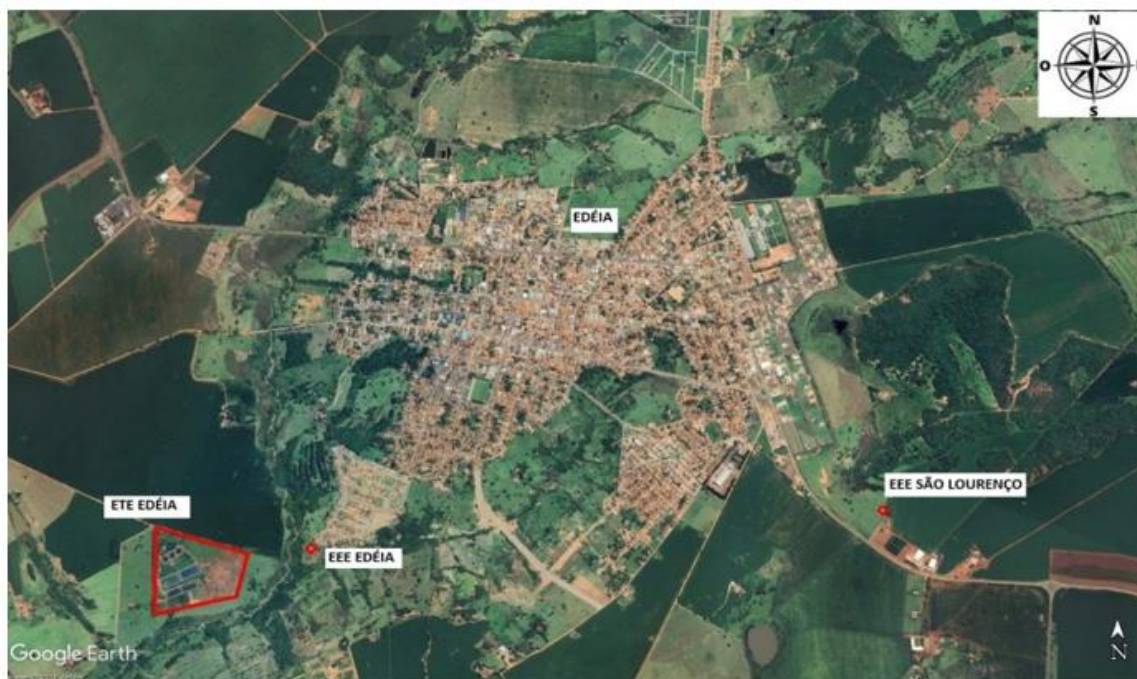
Figura 70- Imagem aérea da Sede municipal – Edéia
