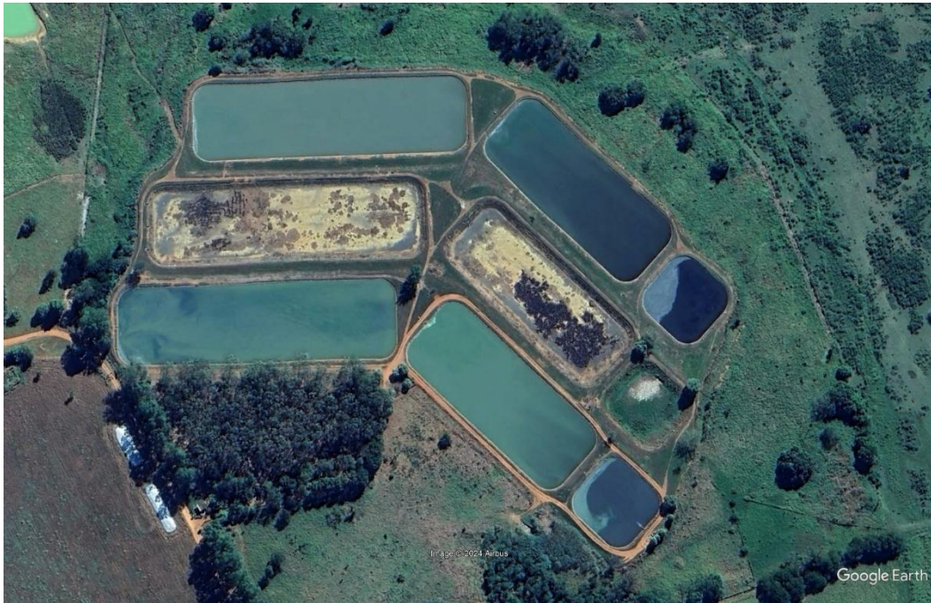
Figura 156 – Imagem aérea do ETE São Luiz de Montes Belos
