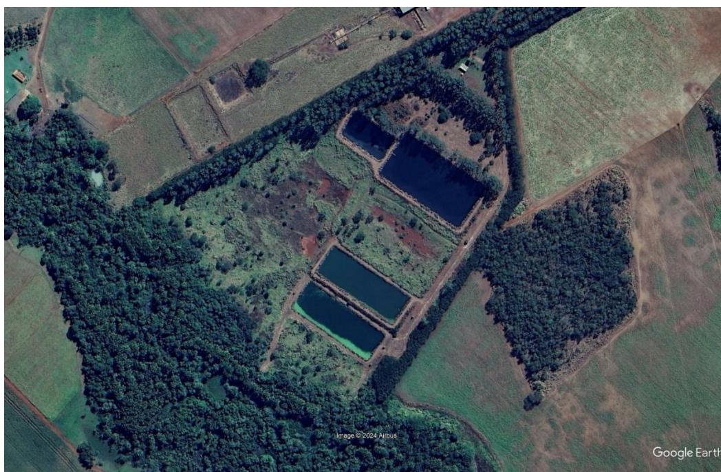
Figura 31 – Imagem aérea da ETE Acreúna.
