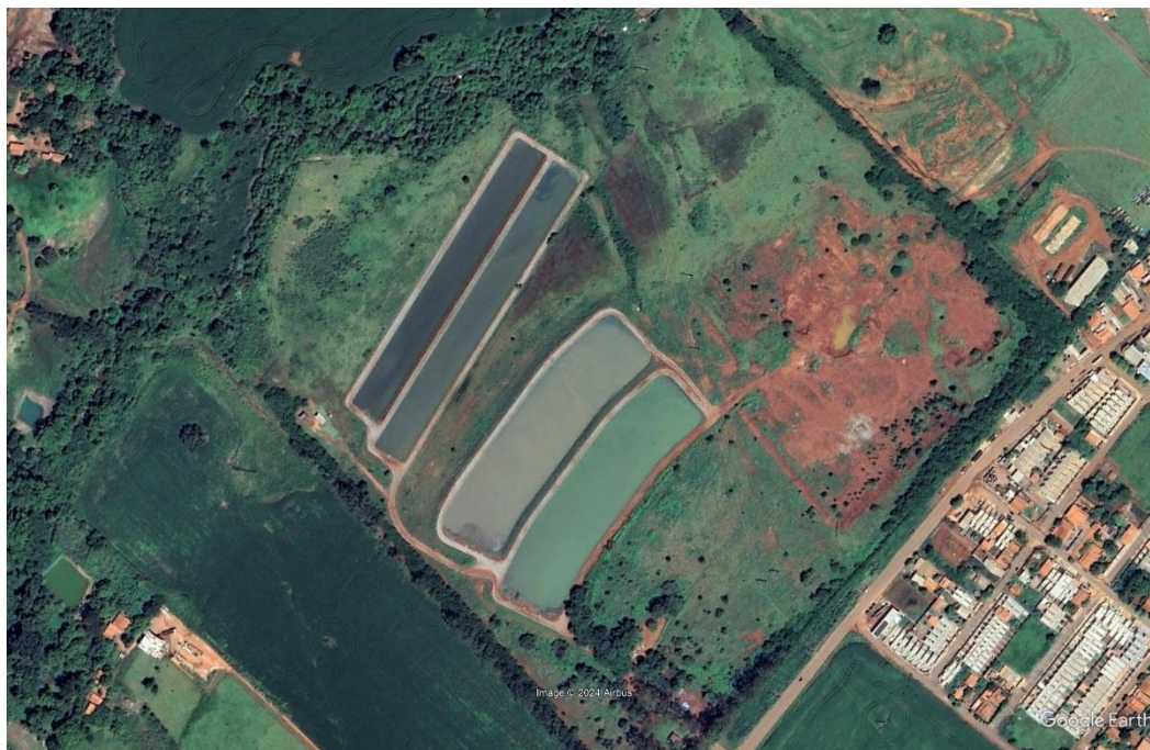
Figura 121 – Imagem aérea do ETE Palmeiras de Goiás
