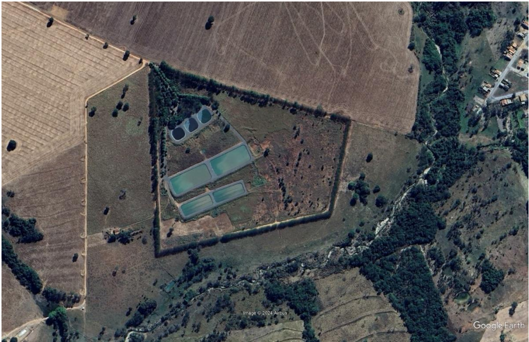
Figura 73 – Imagem aérea da ETE Edéia
