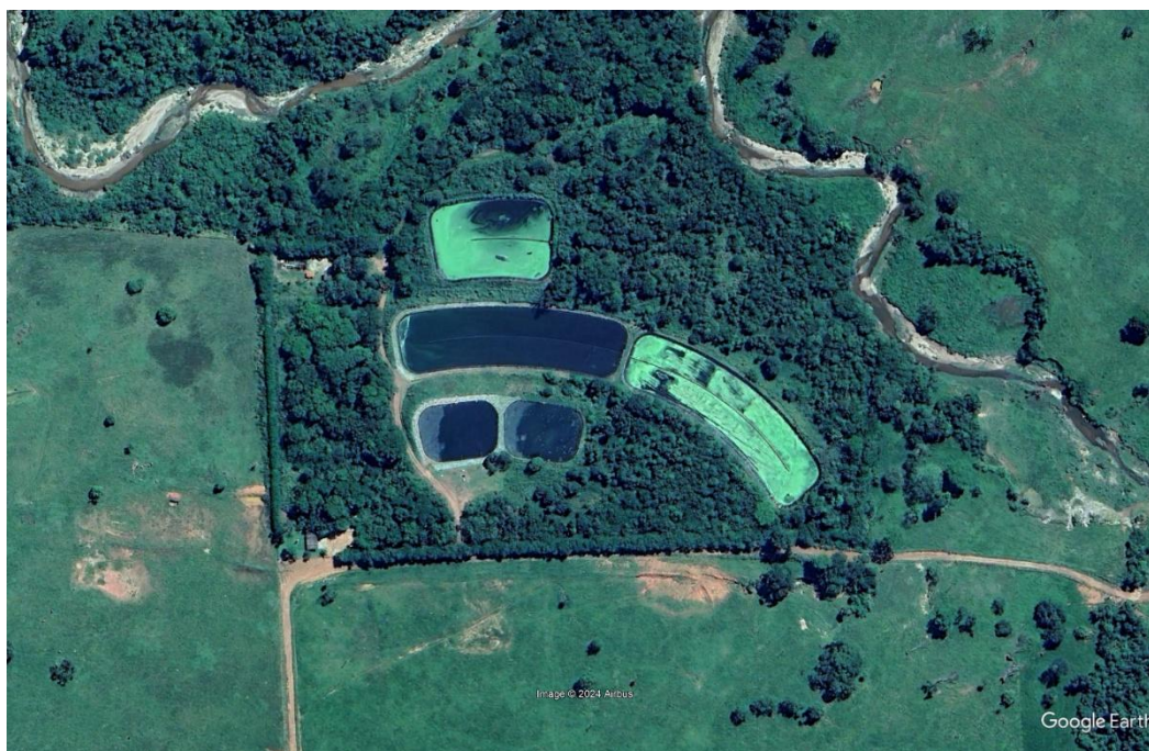
Figura 126 – Imagem aérea do ETE Paraúna
