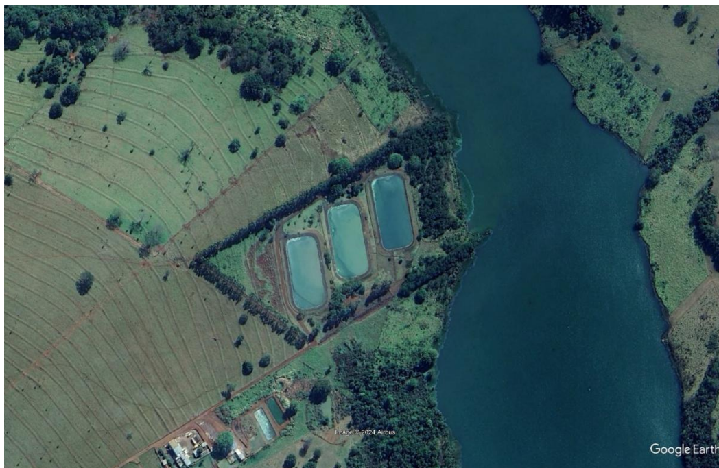
Figura 63 – Imagem aérea da ETE Caçu.
