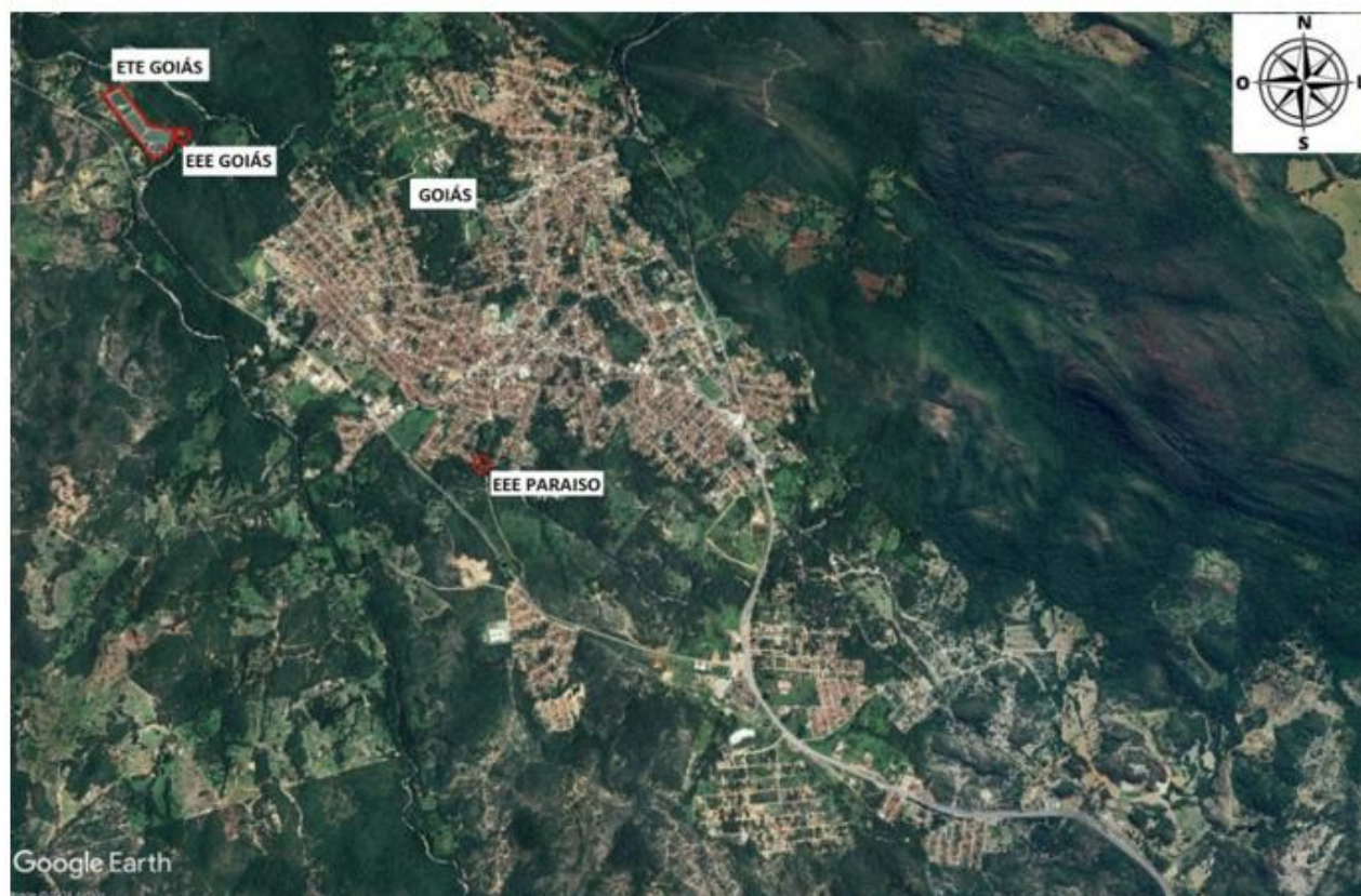
Figura 75 - Imagem aérea da Sede municipal – Goiás
