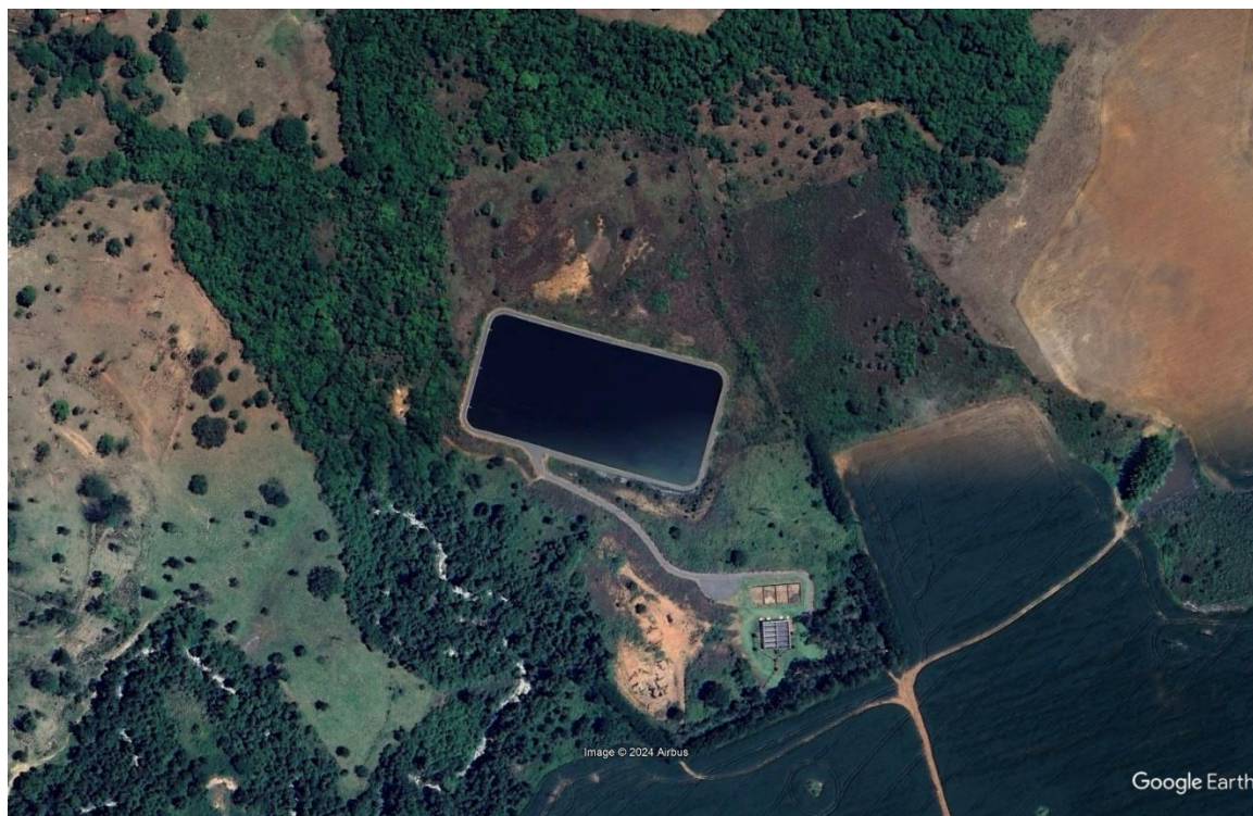
Figura 88 – Imagem aérea do ETE Iporá
