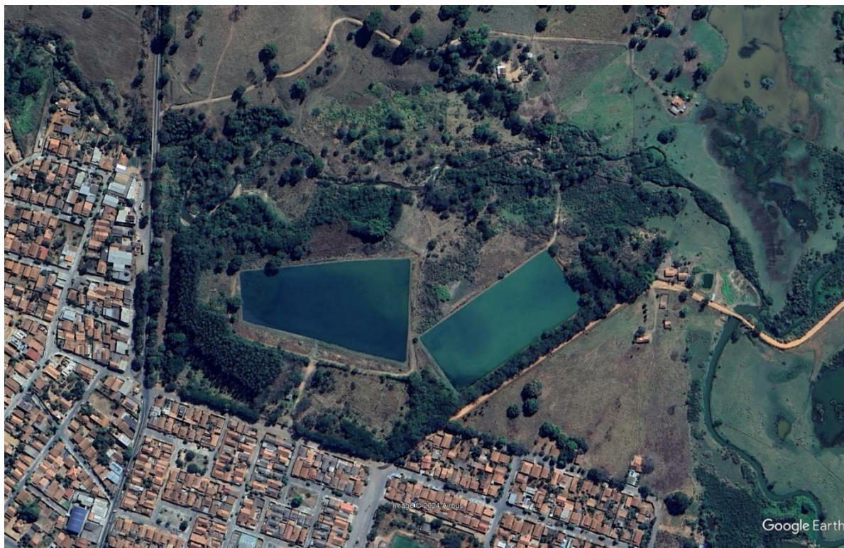
Figura 36 – Imagem aérea da ETE Anicuns.
