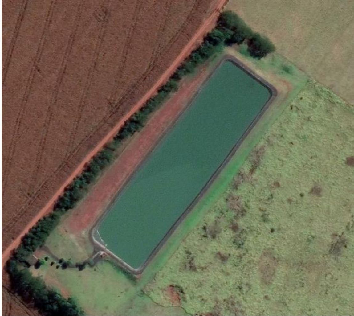
Figura 117 – Imagem aérea da ETE Montividiu
