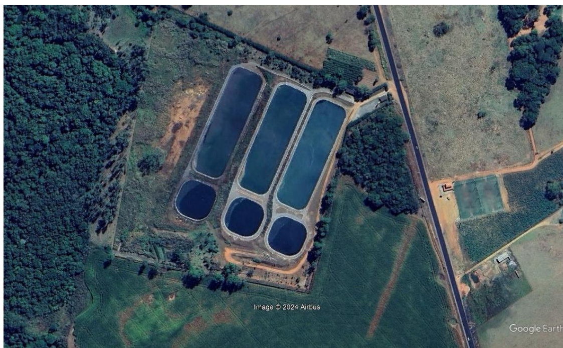
Figura 93 – Imagem aérea da ETE Itaberaí
