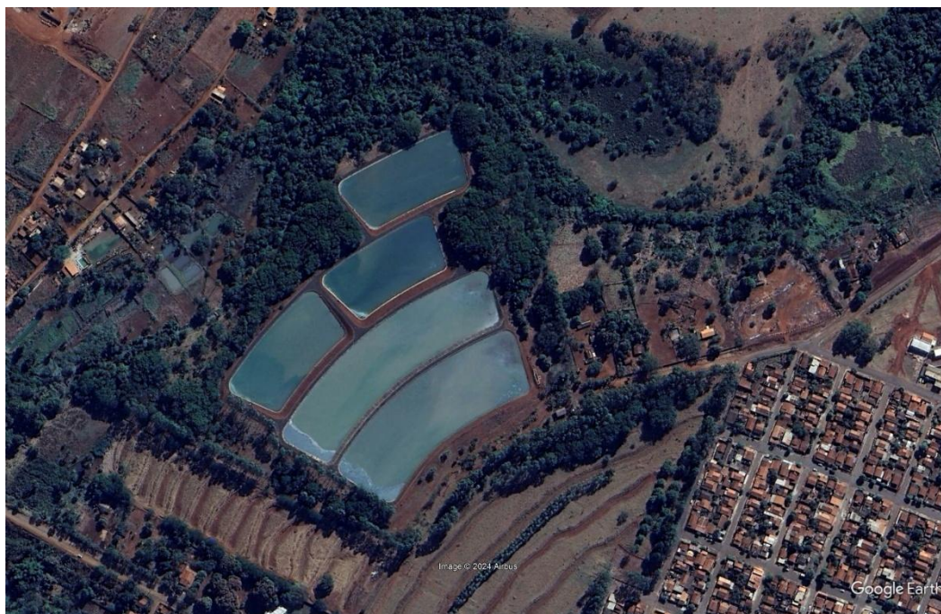
Figura 50 – Imagem aérea da ETE Bom Jesus de Goiás.
