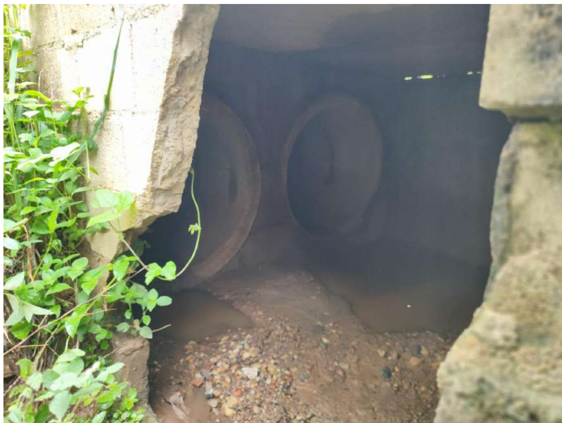
Imagem 14- Saída no dissipador- tubos de diâmetro de 100 cm.
