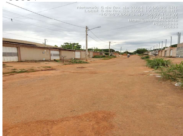
Serviço: Recapeamento Asfáltico Local: Rua 52 – Brasilinha Sudoeste Coordenadas: -15.434100° -47.615874° Data: 05/01/2024
