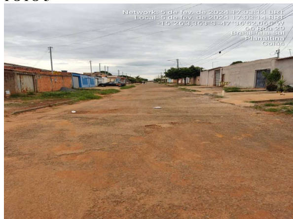
Serviço: Recapeamento Asfáltico Local: Rua 48 – Brasilinha Sudoeste Coordenadas: -15.434220° -47.614485° Data: 05/01/2024
