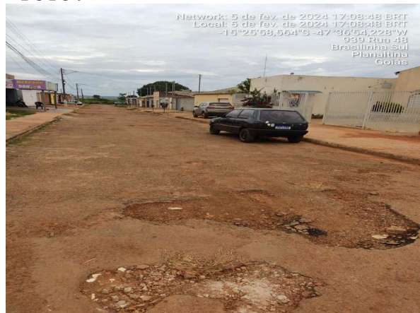
Serviço: Recapeamento Asfáltico Local: Rua 23 – Brasilinha Sudoeste Coordenadas: -15.431286° -47.611506° Data: 05/01/2024
