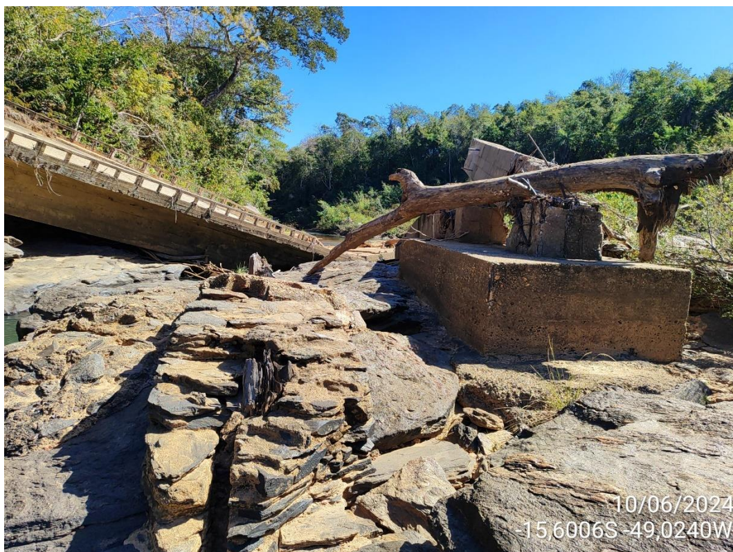
Figura 5 – Fundação da Ponte existente
