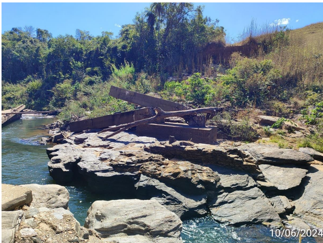
Figura 5 – Fundação da Ponte existente
