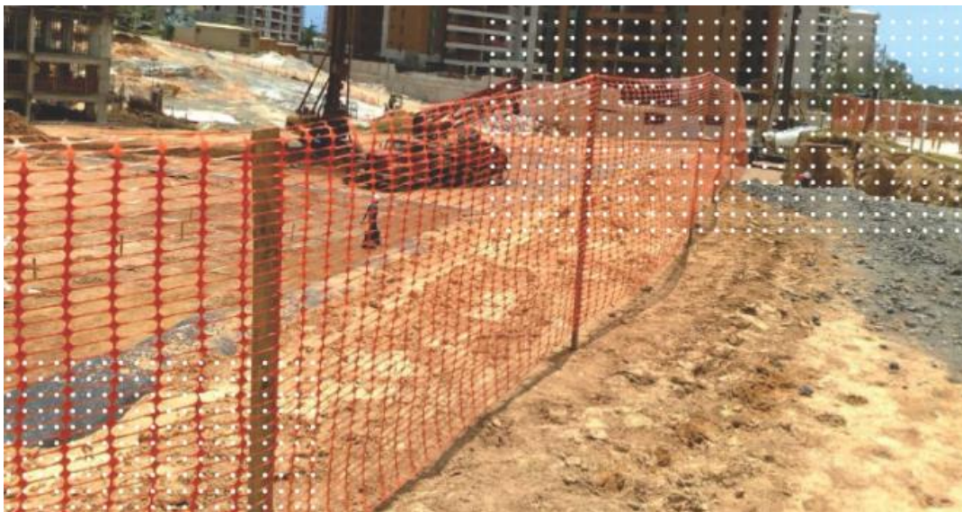
Figura 7 - Rede de isolamento de área em obra.
