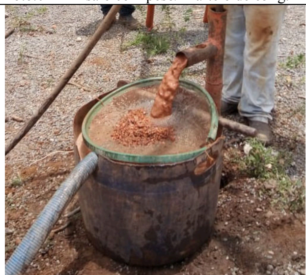
Foto.06 – Detalhe do processo de lavagem.
