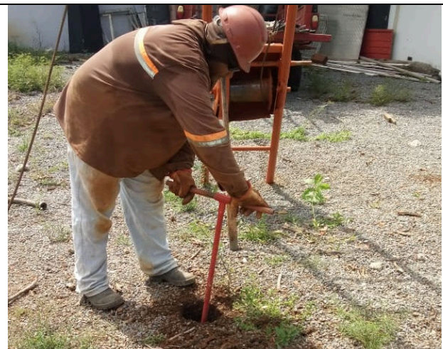
Foto.02 – Detalhe da área de trabalho.
