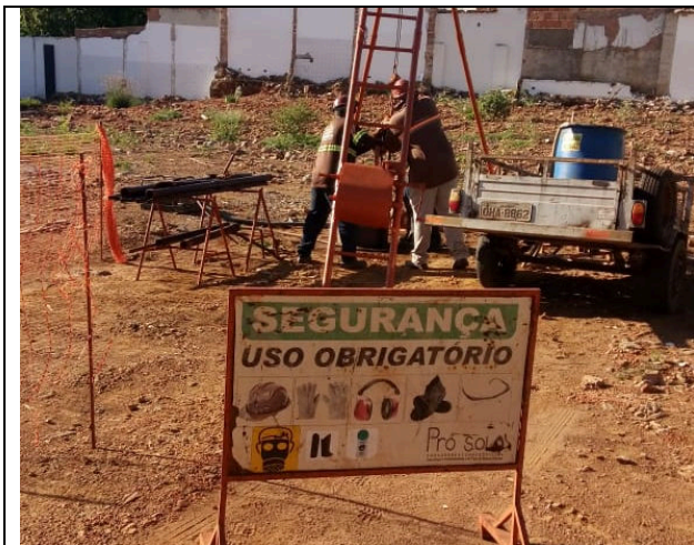
Foto.01 – Detalhe da área de trabalho.
