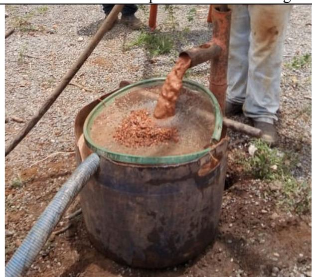
Foto.06 – Detalhe do processo de lavagem.
