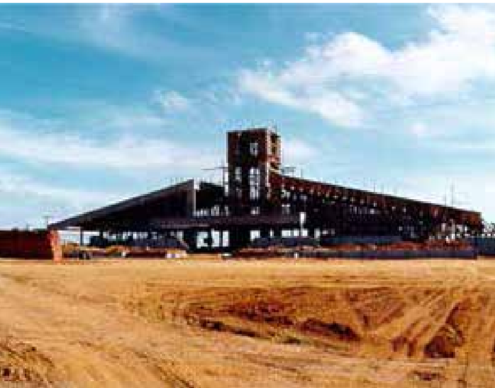
Construção da sede do CRCN-CO/CNEN/
