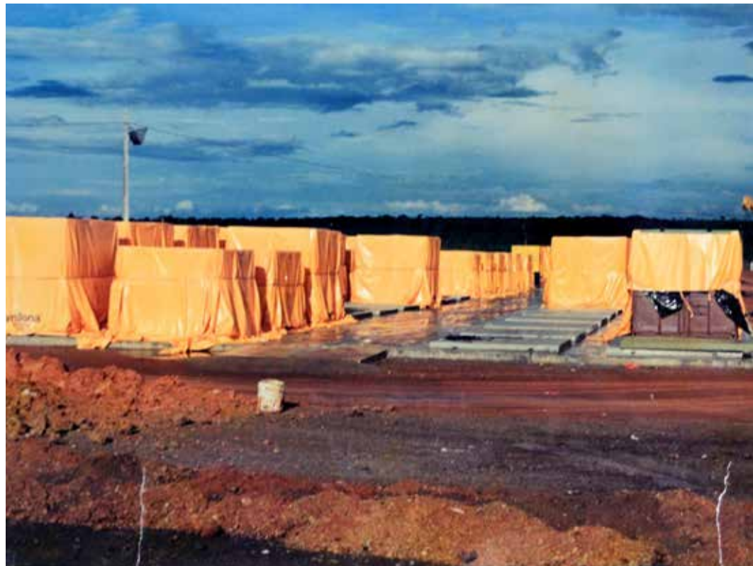
Transporte de rejeitos para depósito provisório
