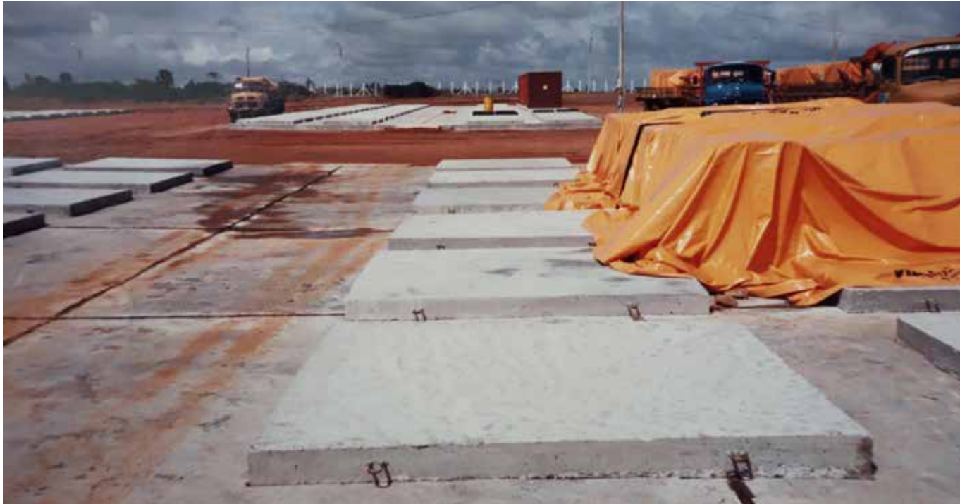
Piso de concreto - 27/11/87
