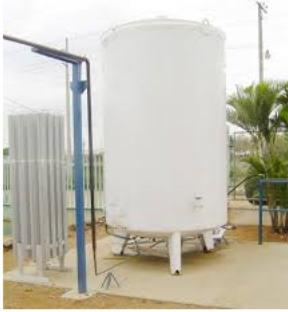
TANQUE CRIOGÊNICO CENTRAL DE CILINDROS RESERVA SISTEMA SEMIAUTOMÁTICO
