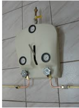
TANQUE CRIOGÊNICO CENTRAL DE CILINDROS RESERVA SISTEMA SEMIAUTOMÁTICO
