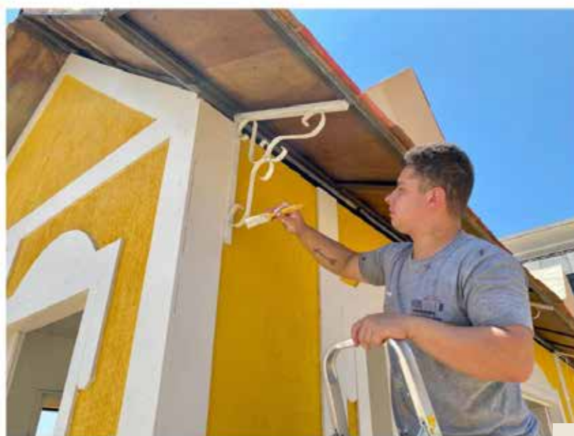
O Governo do Estado, por meio do Goiás Social e da Organização das Voluntárias de Goiás (OVG), deu início à montagem da estrutura do Natal do Bem 2023, que será realizado entre os dias 16 de novembro e 6 de janeiro de 2024, no Centro Cultural Oscar Niemeyer (CCON), em Goiânia.
