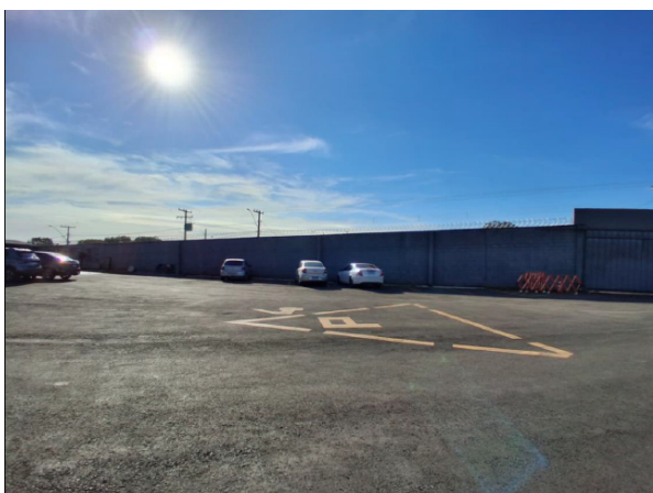
Foto 3 ? Área do pátio e divisa lateral.
