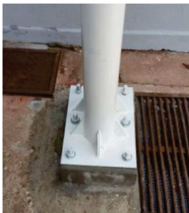
Figura 1 ? Detalhe do bloco de fundação a ser executado, onde serão chumbados os pilares dos módulos de sombreamento.
