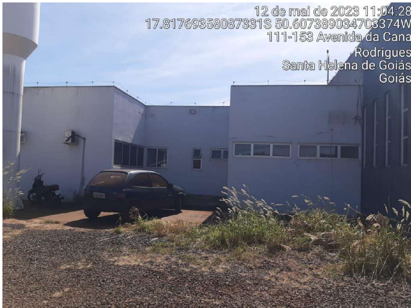
Local destinado à ampliação da copa sala do monitoramento
