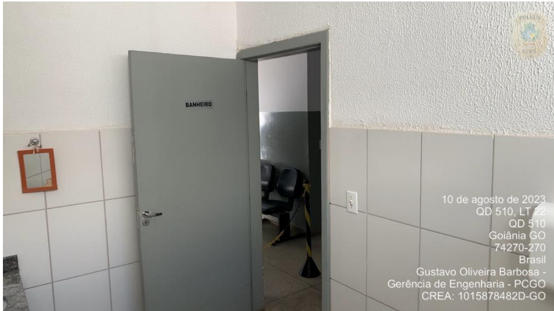
Banheiro Recepção Interno
