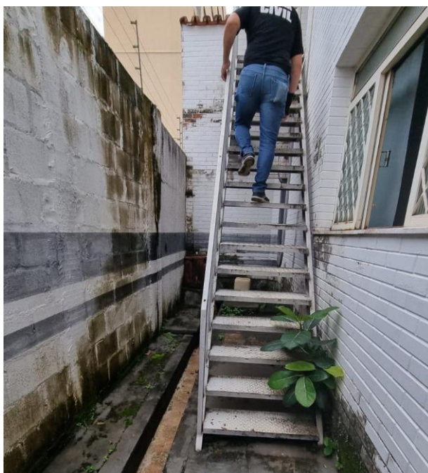
Acesso ao Piso Superior
