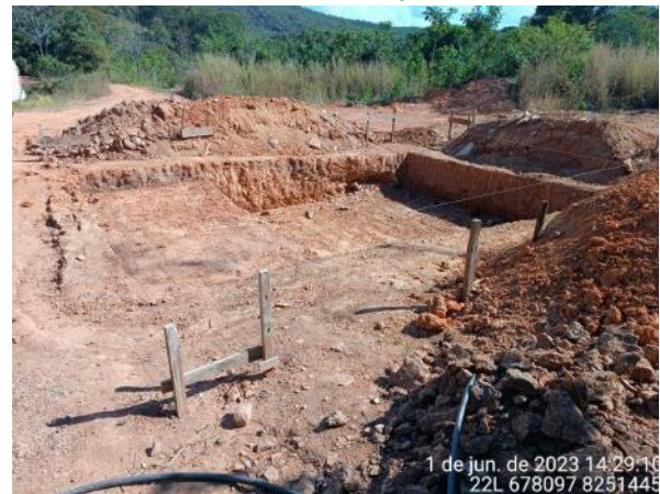
Piscina de água corrente em construção
