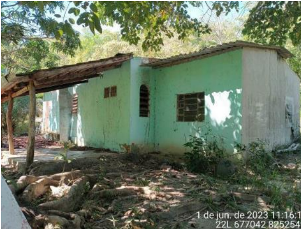
Antiga casa a ser desmontada
