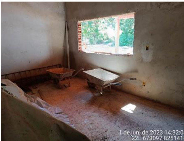
Parte interna da sede em construção
