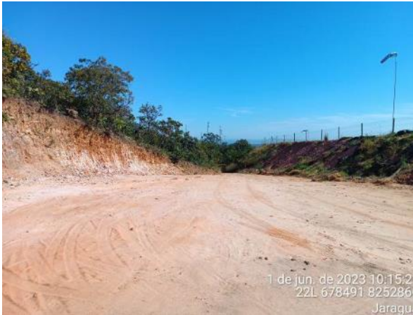
Área de estacionamento - terraplanagem
