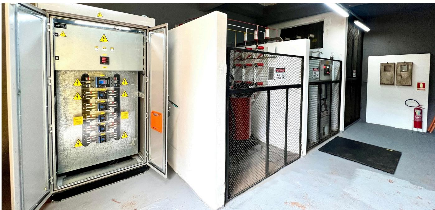
A Metrobus concluiu mais uma etapa importante do seu processo de modernização com a instalação de um novo transformador e de quadros de controle de potência de 500 kVA. A atualização do sistema elétrico substitui um equipamento antigo, considerado obsoleto, e permite ampliar a capacidade de carga da empresa de 200 kVA para 500 kVA.
