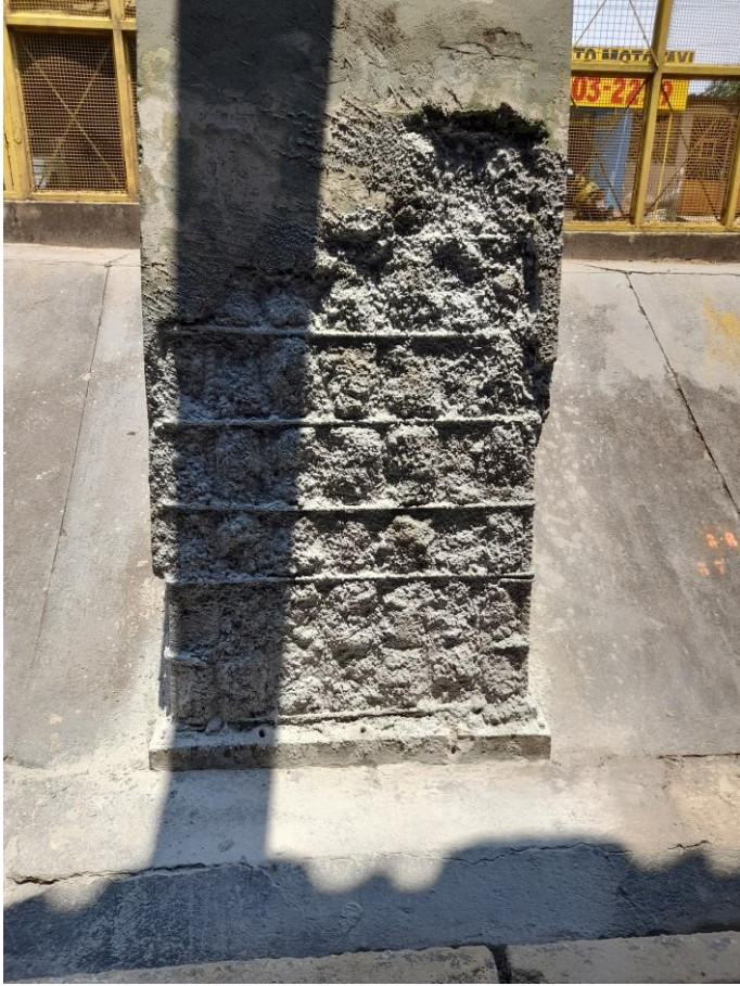
Amostra de pilar em execução de recuperação e reforço estrutural
