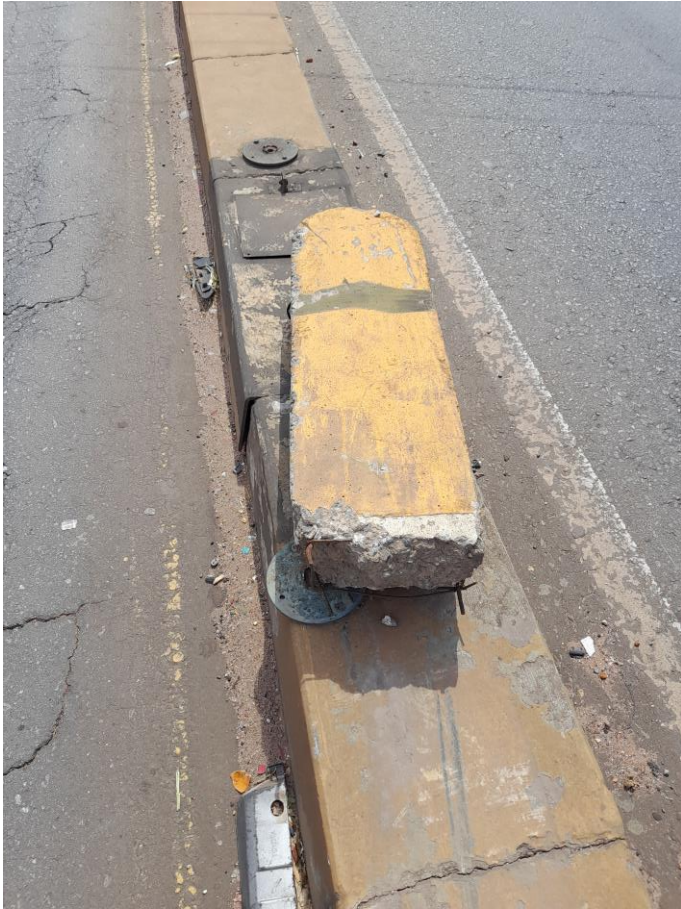
Amostra de artefato de concreto danificado e guia de concreto em falta.
