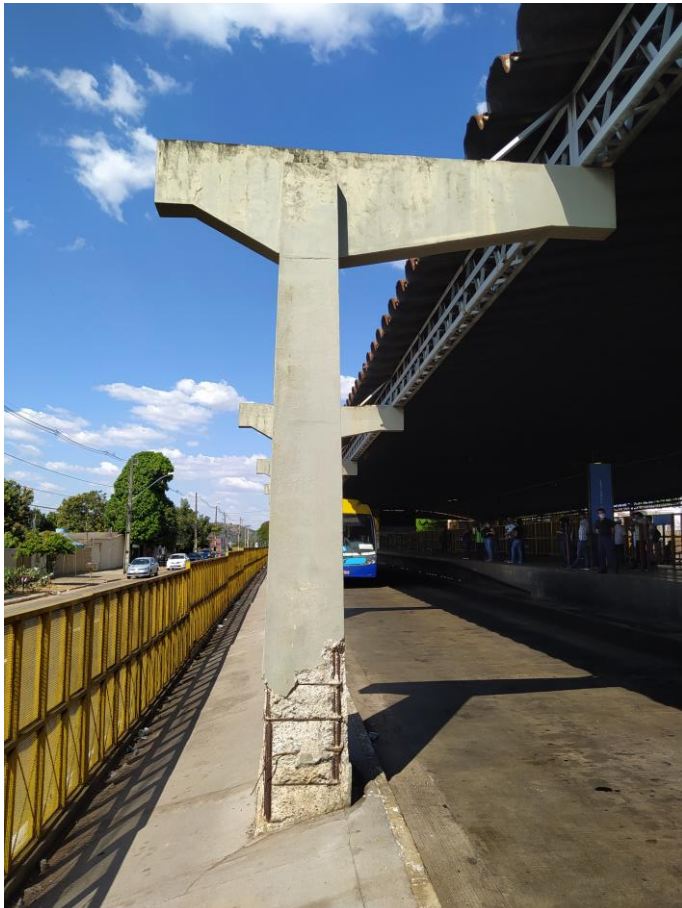
Vista antes e depois de pilar e viga após execução de recuperação e reforço estrutural.
