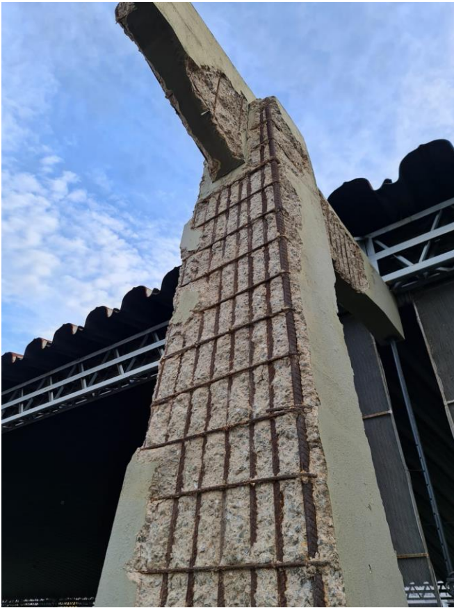
Amostra de pilar e viga com estrutura comprometida
