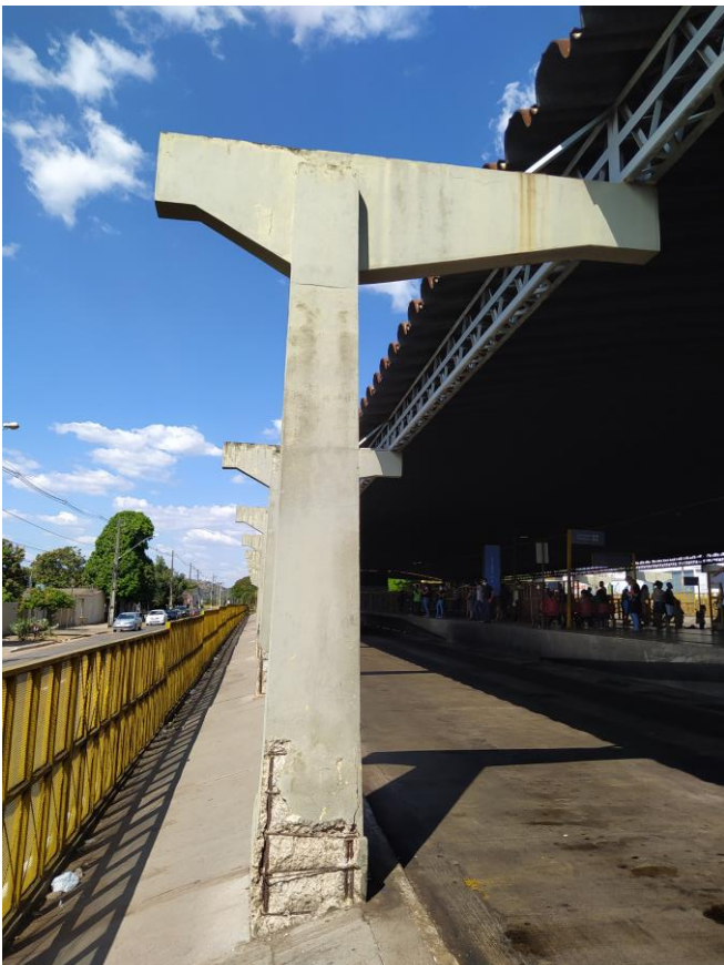
Amostra de um pilar com estrutura comprometida
