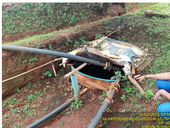
Foto 35. Vista do reservatório localizado antes do direcionamento do efluente para a rede coletora da Saneago.
