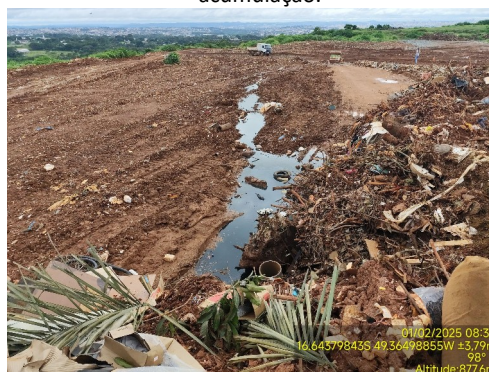
Foto 28. Vazamento de percolado, indicando possível falha na drenagem do maciço.
