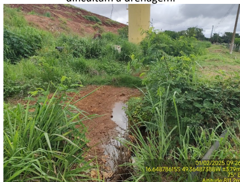
Foto 16. Canaletas com presença de sedimentos que dificultam a drenagem.
