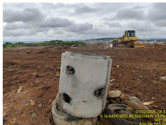
Foto 38. Dreno de gases danificado, executando a queima de gases.
