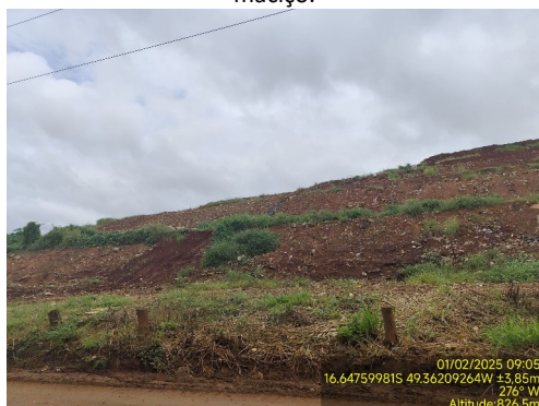
Foto 23. Descida sem disciplinamento de água pluvial pelos taludes.
