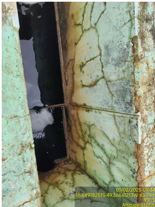
Foto 29. Calha de Parshall instalada para medição do lixiviado.
