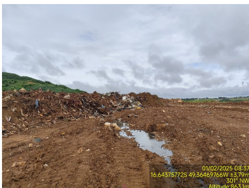
Foto 27. Vazamento de percolado, indicando possível falha na drenagem do maciço.
