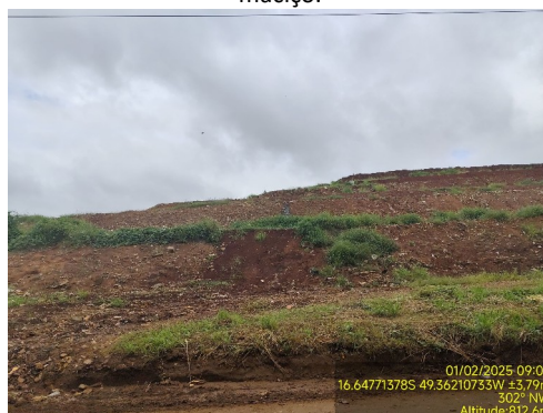
Foto 24. Descida sem disciplinamento de água pluvial pelos taludes.
