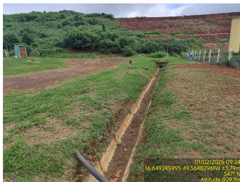
Foto 15. Canaletas pluviais com presença de sedimentos que dificultam a drenagem.
