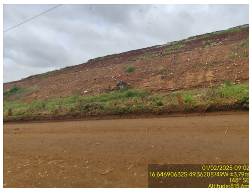
Foto 21. Formação de processos erosivos nos taludes do maciço.
