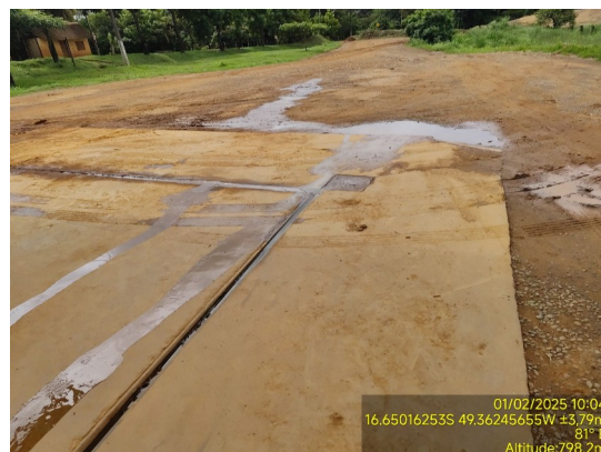
Foto 42. Detalhe do sistema de drenagem instalado, com canaletas obstruídas e extravasando para o solo não impermeabilizado.
