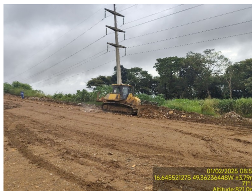
Foto 50. Utilização de RCC para reconfirmação dos acessos internos do aterro.
