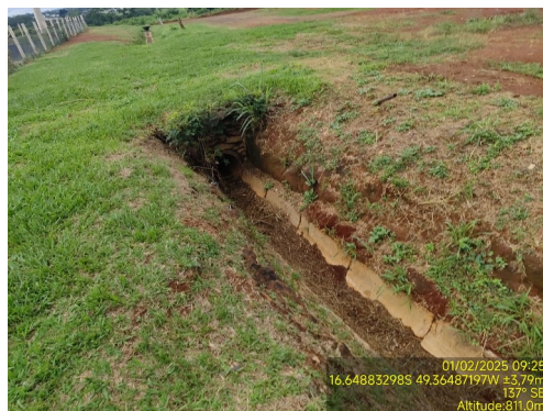
Foto 16. Canaletas com presença de sedimentos que dificultam a drenagem.
