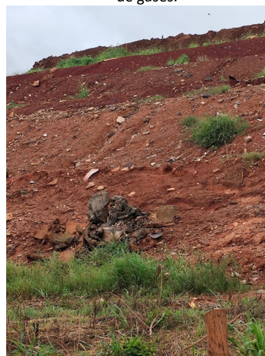
Foto 40. Dreno de gases danificado, executando a queima de gases.
