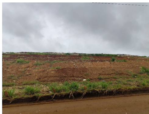
Foto 22. Formação de processos erosivos nos taludes do maciço.
