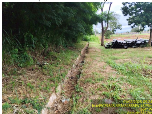
Foto 19. Canaletas pluviais obstruídas.
