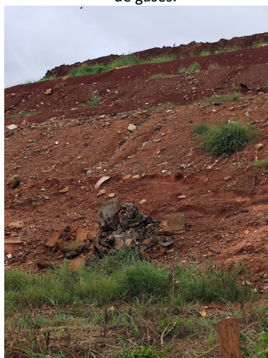
Foto 37. Dreno de gases danificado, executando a queima de gases.
