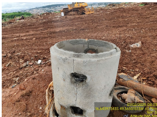
Foto 37. Dreno de gases danificado, executando a queima de gases.
