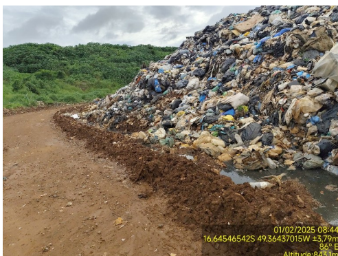
Foto 25. Canaletas implantadas para drenagem de águas pluviais e percolado.
