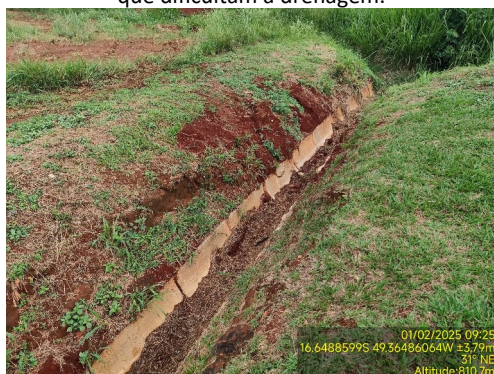
Foto 15. Canaletas pluviais com presença de sedimentos que dificultam a drenagem.
