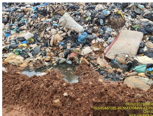
Foto 26. Canaletas demonstrando ineficiência no disciplinamento das águas pluviais e percolado, com acumulação.
