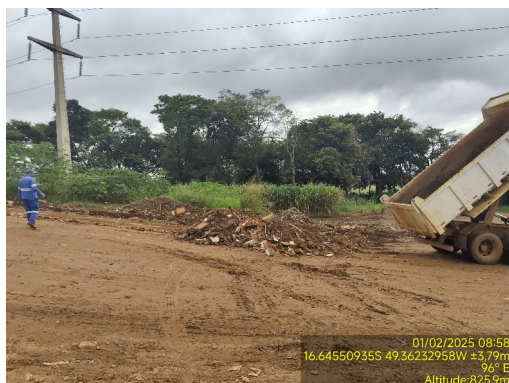
Foto 49. Utilização de RCC para reconfirmação dos acessos internos do aterro.
