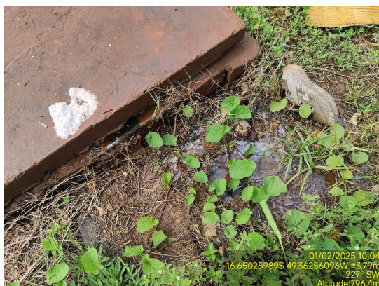
Foto 43. Sistema de tratamento de efluentes oleosos do posto de abastecimento, apresentando transbordamento.
