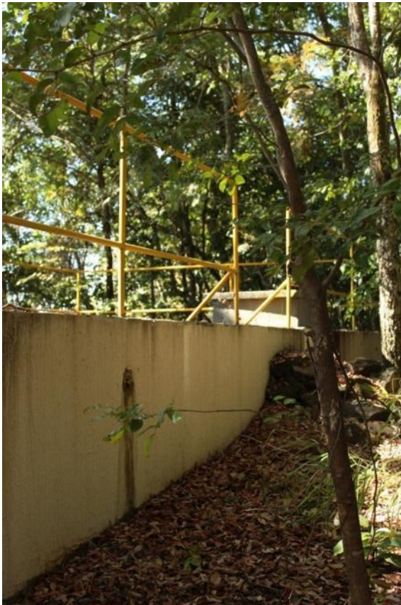
Figura 14 - Reservatório de Água
