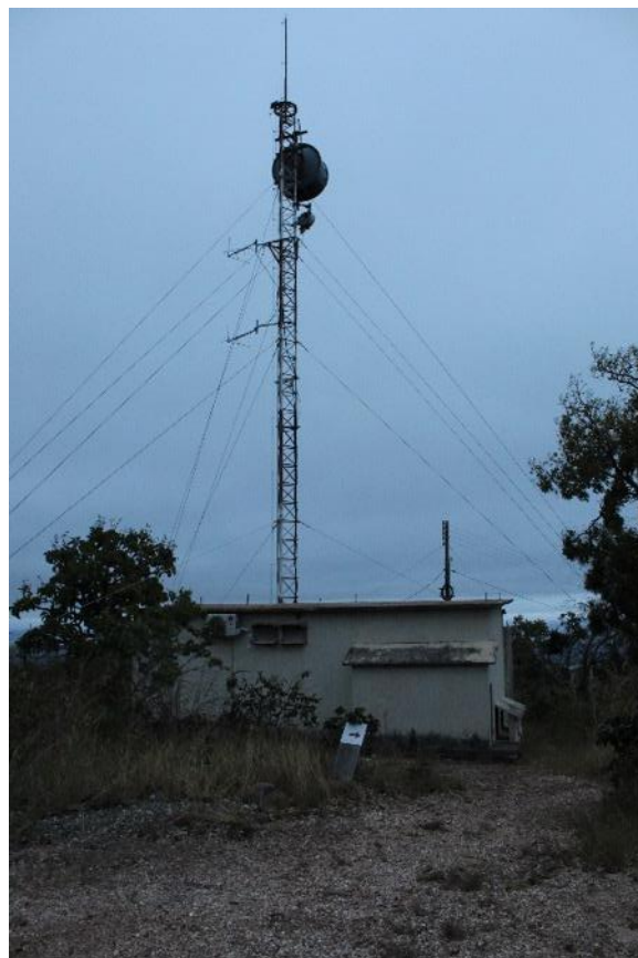
Figura 17 - Torre de telefonia
