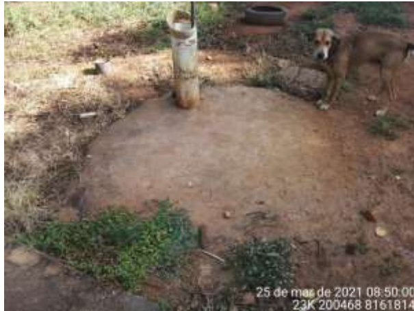
Figura 56. Fossa negra em propriedade na AID.
