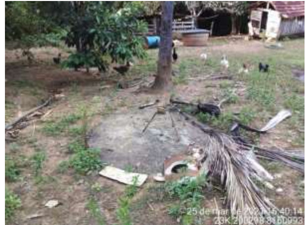
Figura 57. Fossa negra em propriedade na AID.
