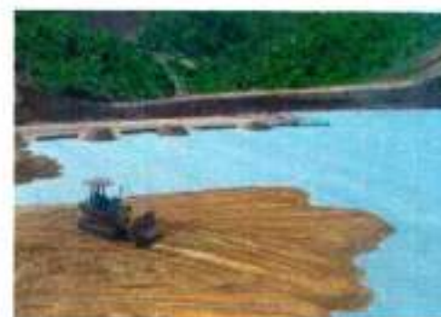
Camada de argila compactada para proteção do geotêxtil
