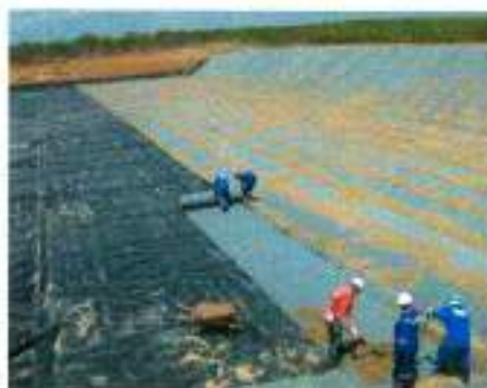
Instalação de geotêxtil sobre a geomembrana
