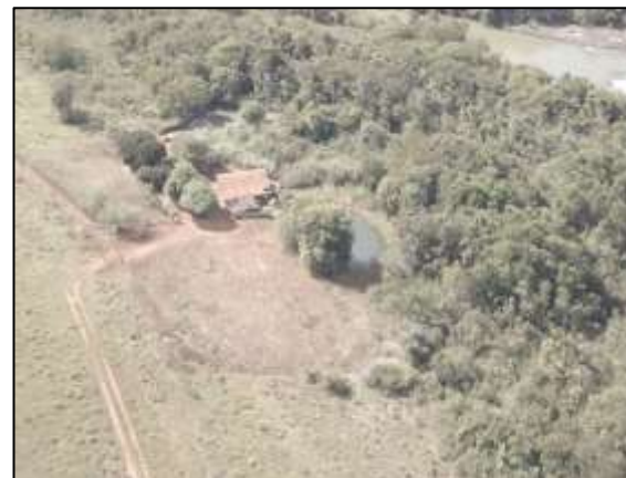
Foto 3.4: Edificações lindeiras ao empreendimento.
