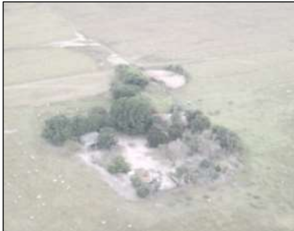
Foto 3.1: Edificações lindeiras ao empreendimento.
