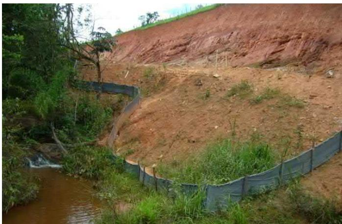
Exemplo de retentores de sedimentos com manta geotêxtil
