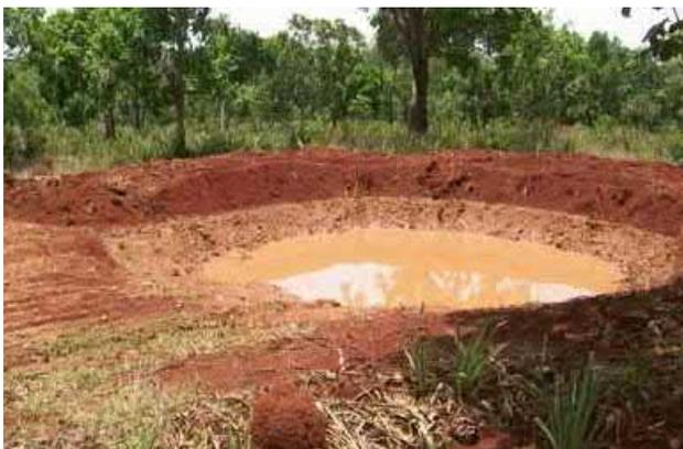
Foto ilustrativa de dispositivo de drenagem previsto – bacia de contenção de sedimentos
