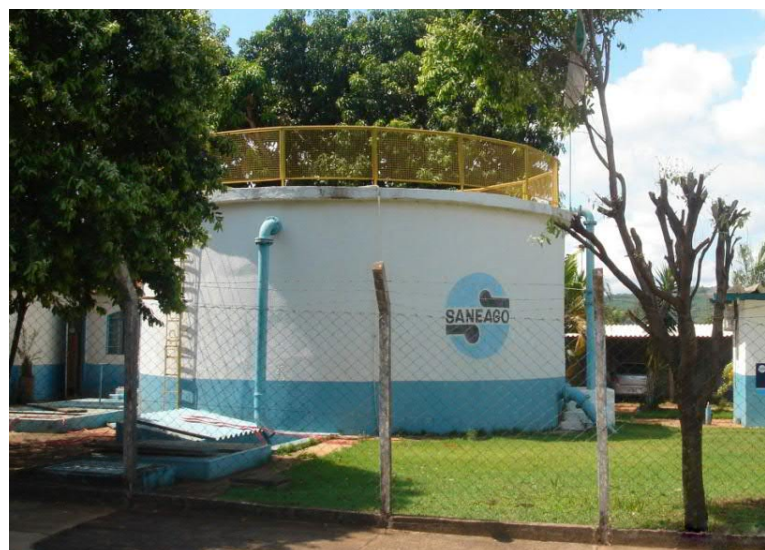
Estação de Tratamento de Água da SANEAGO – Itarumã
