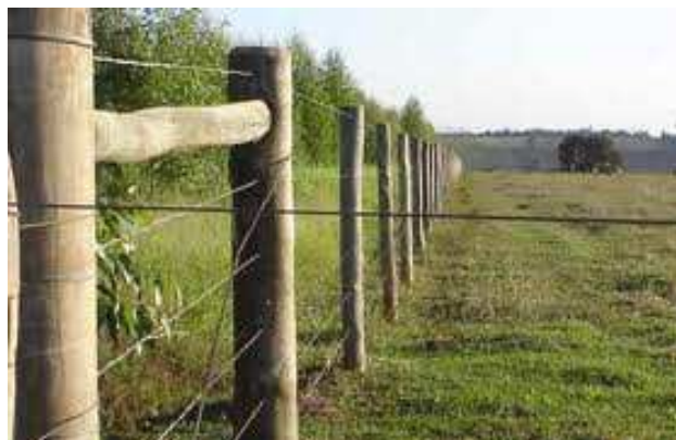
Figuras 12, 13 e 14 – Modelo de fixação de esticadores canto duplo.
