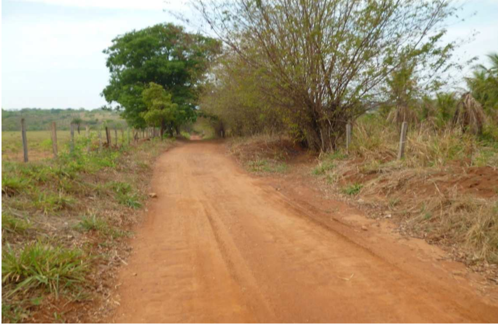
Foto 07 – Levantamento do Greid (cód-40010), lombada com saída d'água (cód-40315), construção de bacia dissipadora (cód-40126) e emoção e relocação de cerca (cód-40805). Fonte: AGETOP (2014).
