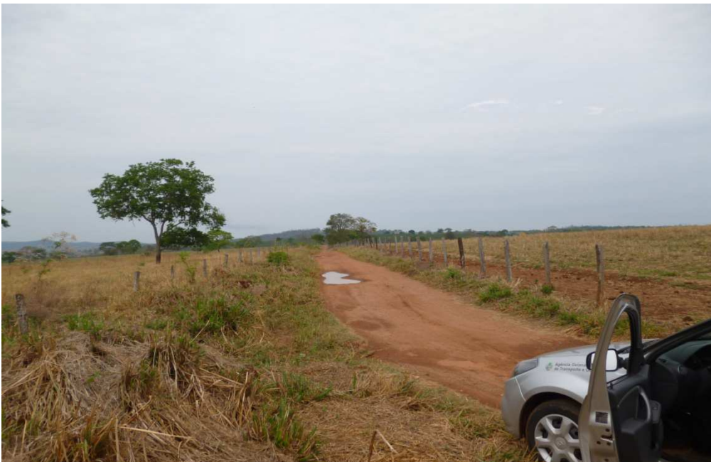
Foto 06 – Levantamento do Greid (cód-40010), lombadas com saída d'água (cód-40315), construção de bacias dissipadoras (cód-40126) e remoção e relocação de cerca (cód-40805). Fonte: AGETOP (2014).
