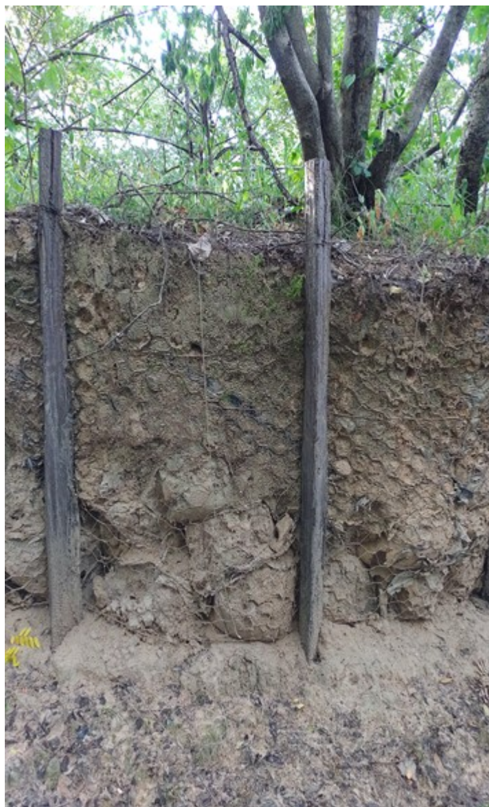
Figura 4: Contenção de encosta as margens do Rio Paranã
