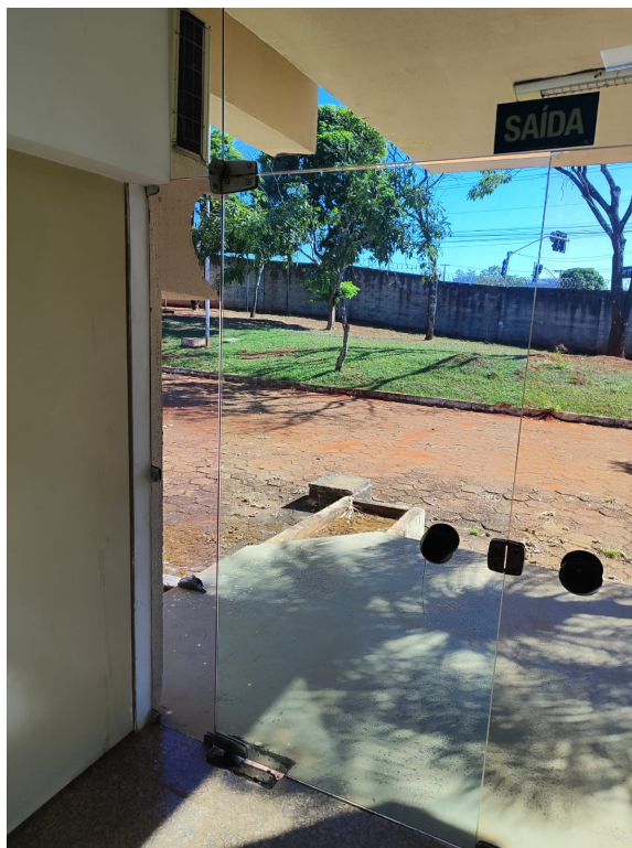
Foto 5: Porta do Jurídico para troca de fixadores e ajuste de fechamento
