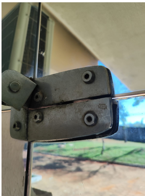
Foto 6: Fixador da porta a ser trocado
