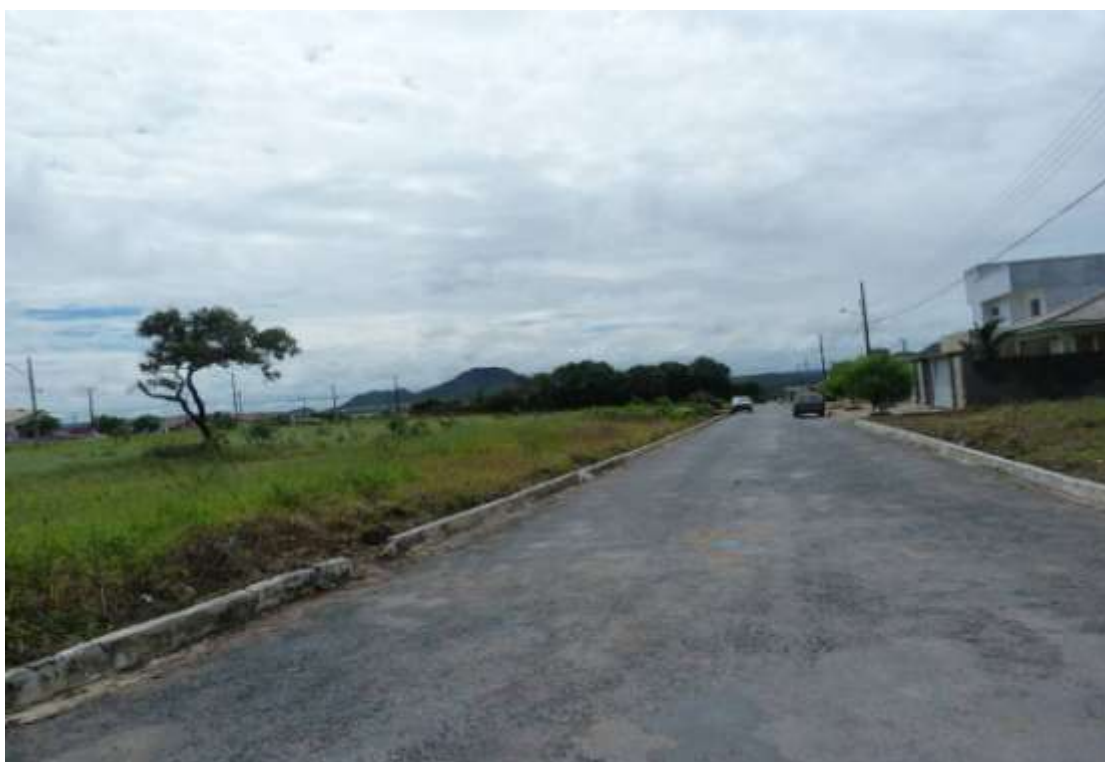
Foto 4: Vista da área à esquerda pela rua 110
