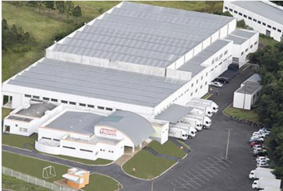
Figura 54: Exemplo de centro de distribuição. Fonte: Loja do Mecânico
