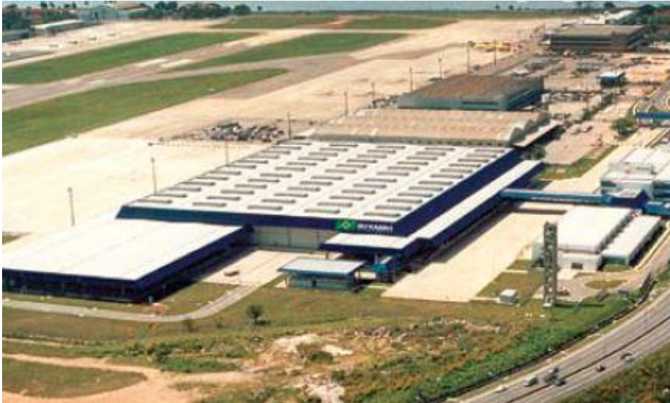
Figura 62: Terminal de Carga Aérea – Infraero.
