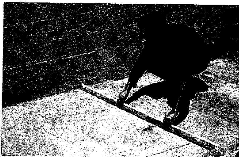
Foto 8: Nivelamento da camada de base
