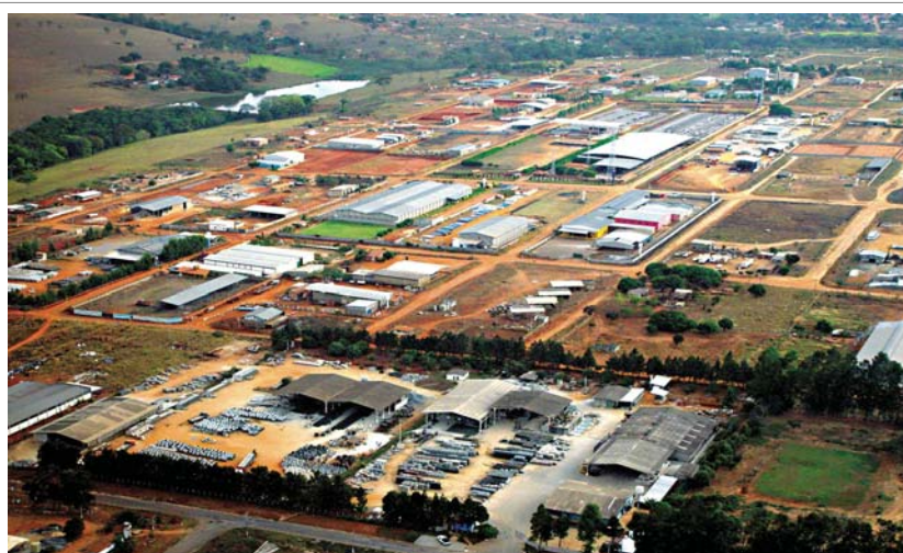
DIMAG – Distrito Industrial Municipal de Aparecida de Goiânia - GO
