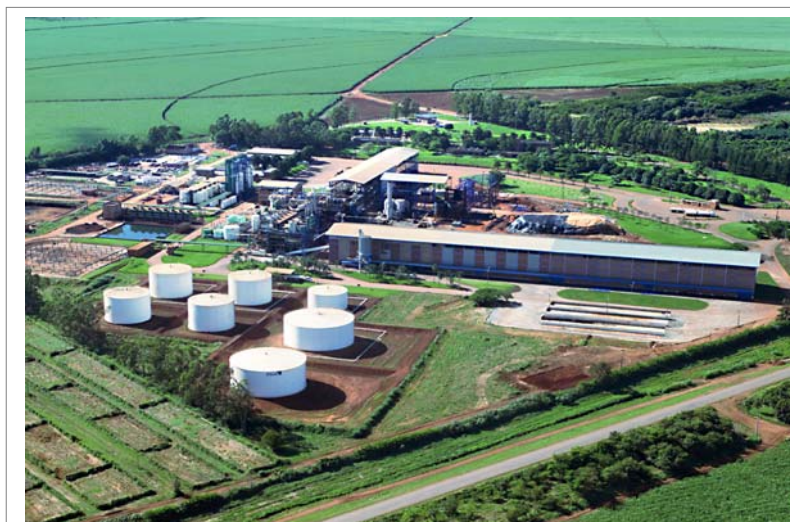
Usina Jalles Machado em Goianésia - GO
