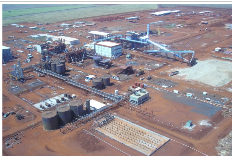
Usina São Francisco em Quirinópolis - GO
