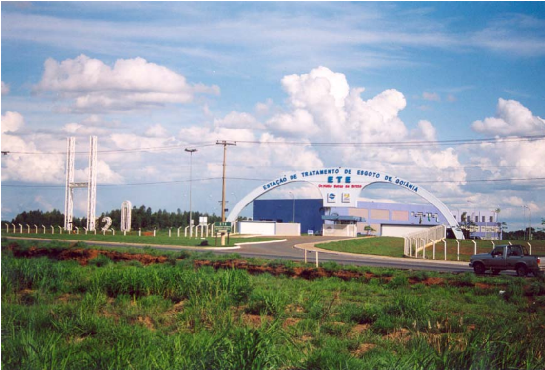
Estação de Tratamento de Esgoto de Goiânia / Station of the Sewerage Treatment of Goiânia
