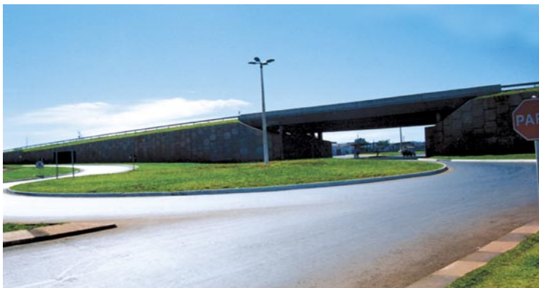
Viaduto da BR-153, duplicação da mais importante rodovia de Goiás
