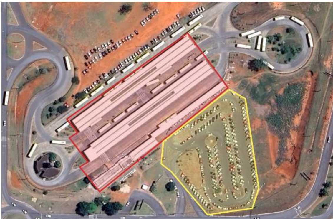
Figura 12 – Terminal do BRT de Santa Maria (DF)
