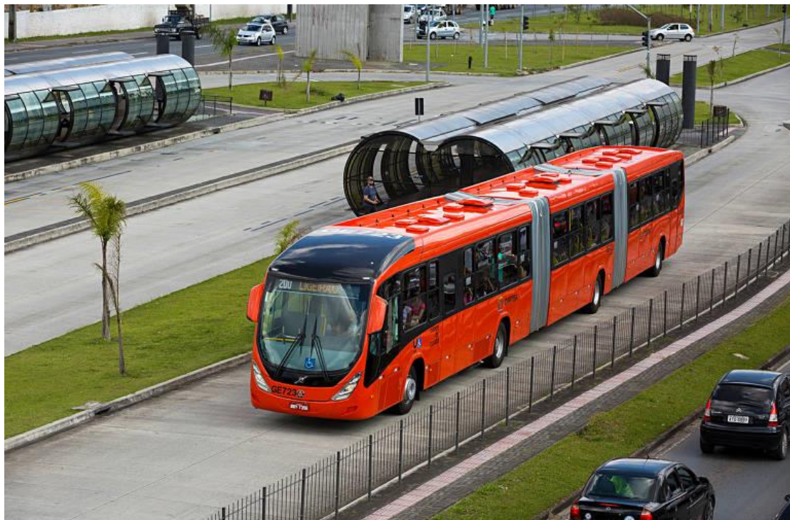
Figura 36 – Via segregada no BRT de Curitiba
