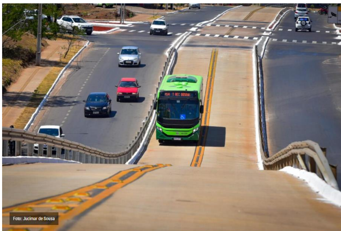
Figura 4 – Sistema de BRT em operação em Goiânia (GO)
