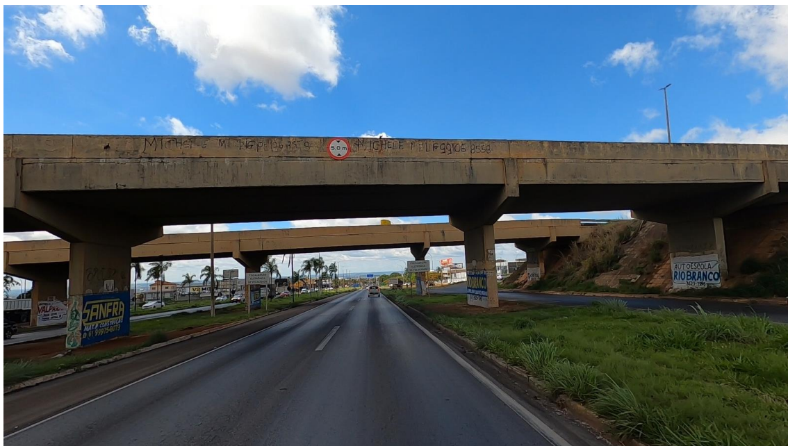
Figura 40 – Viaduto indicado pelo ponto número 3
