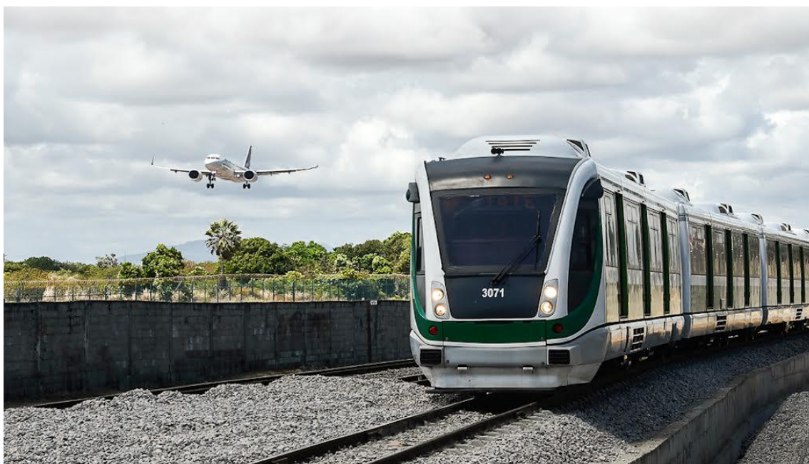
Figura 20 – Sistema de VLT de Fortaleza em operação
