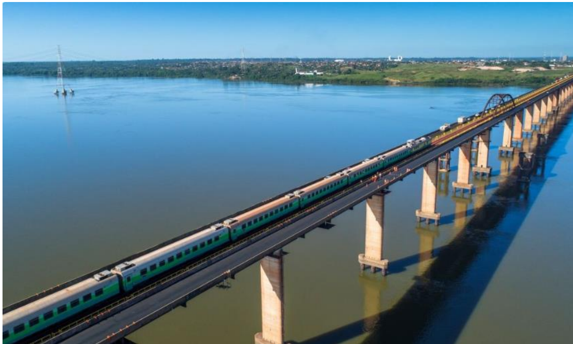
Figura 25 - Trem de Passageiros da EFC em operação
