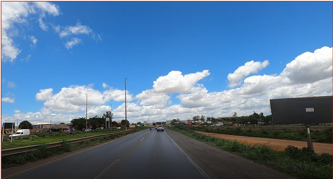
Figura 57 – Passagem da ferrovia da FCA
