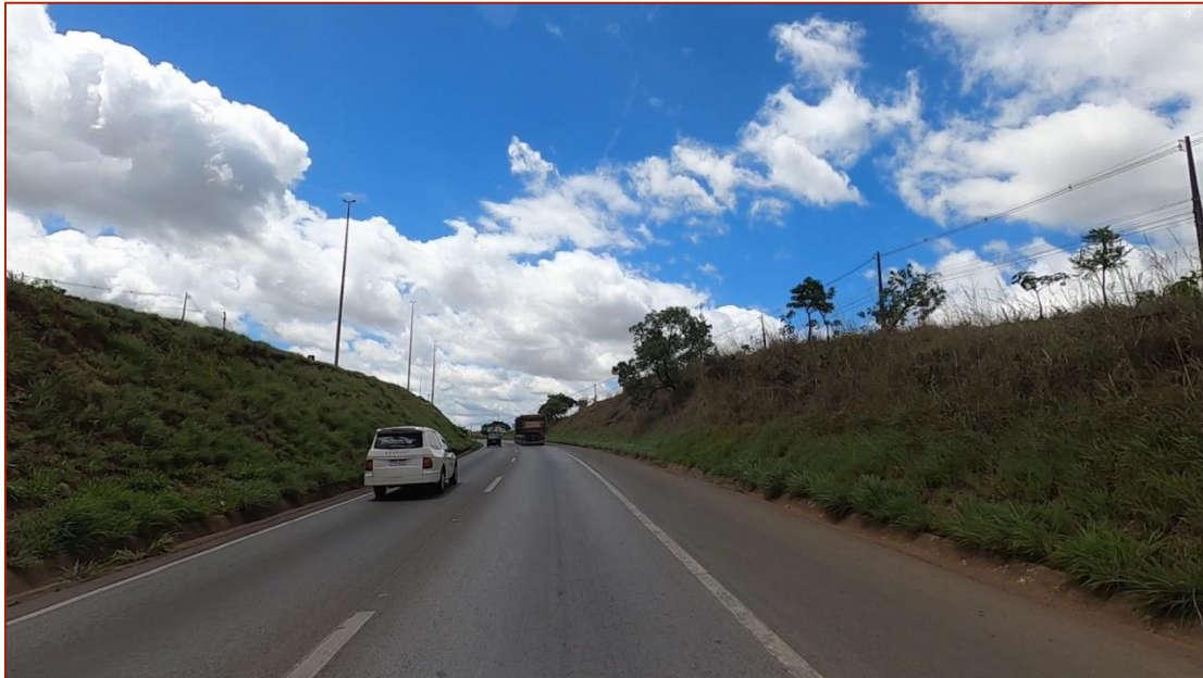
Figura 52 – Canteiros central e lateral reduzidos e com alto desnível
