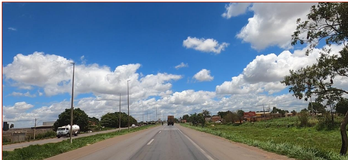
Figura 55 – Canteiros central e lateral reduzidos e com alto desnível
