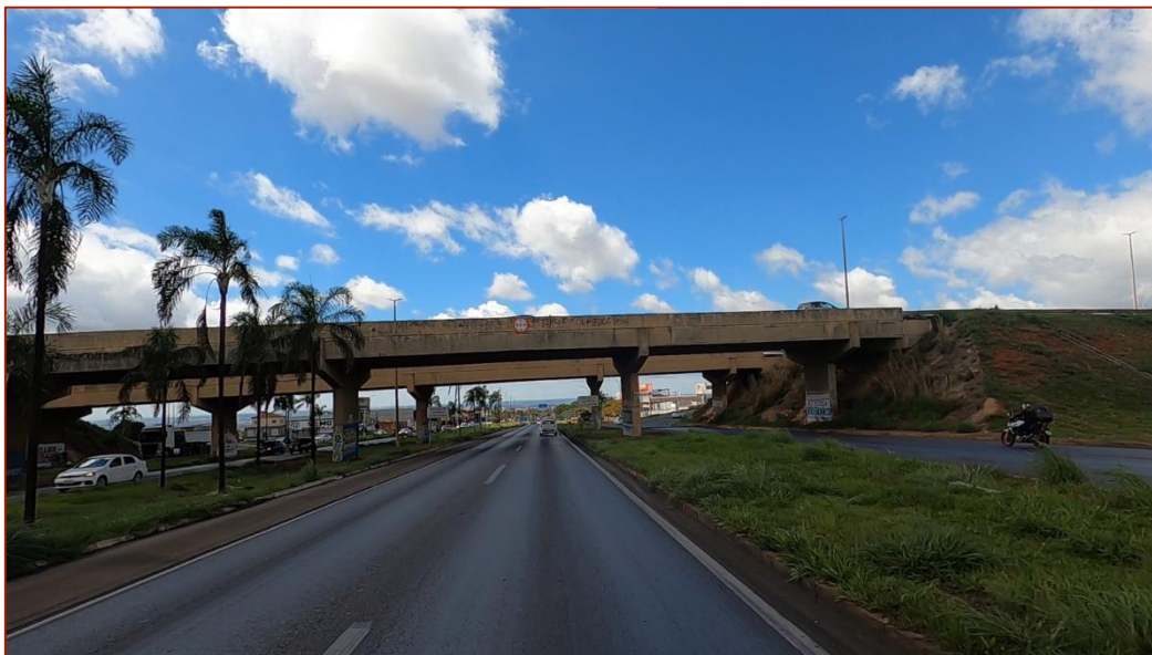
Figura 70 – Passagem de viaduto sobre a rodovia
