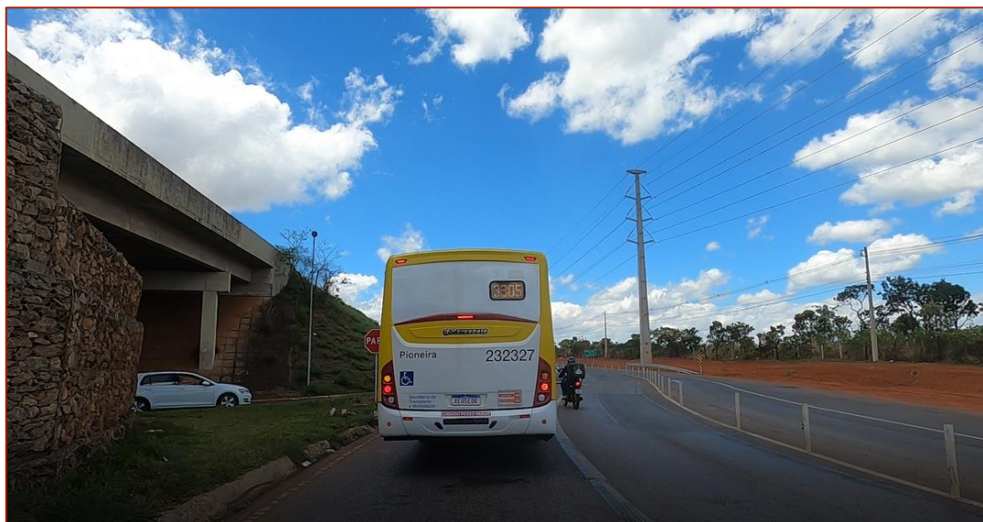
Figura 65 – Viaduto sentido Luziânia (GO)-Santa Maria (DF)
