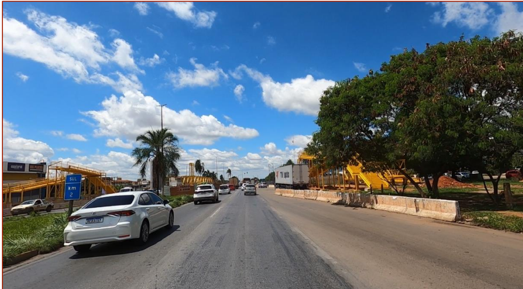
Figura 68 – Passarela em construção
