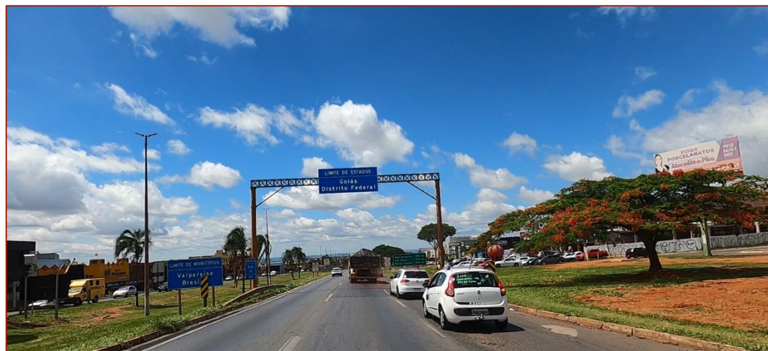
Figura 67 – Viaduto sentido Luziânia (GO)-Santa Maria (DF)
