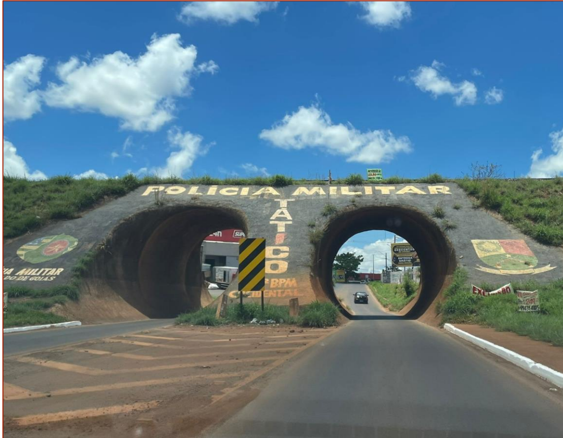
Figura 6 – Passagem em desnível da malha ferroviária em Valparaíso de Goiás (GO) (novembro de 2025)
