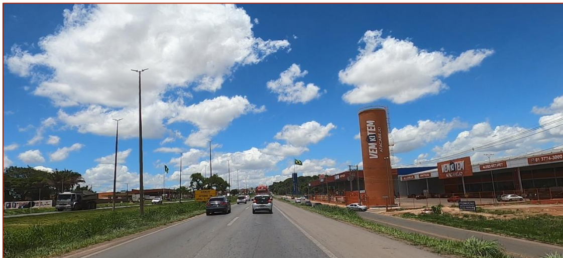
Figura 61 – Inexistência de espaço no canteiro lateral
