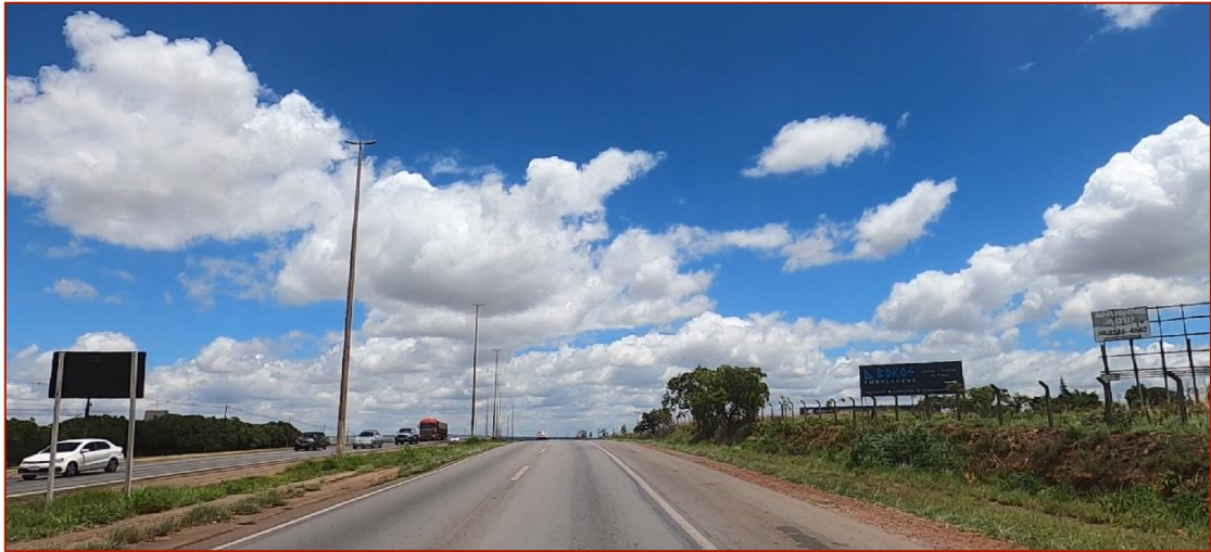
Figura 56 – Canteiros central e lateral reduzidos e com alto desnível
