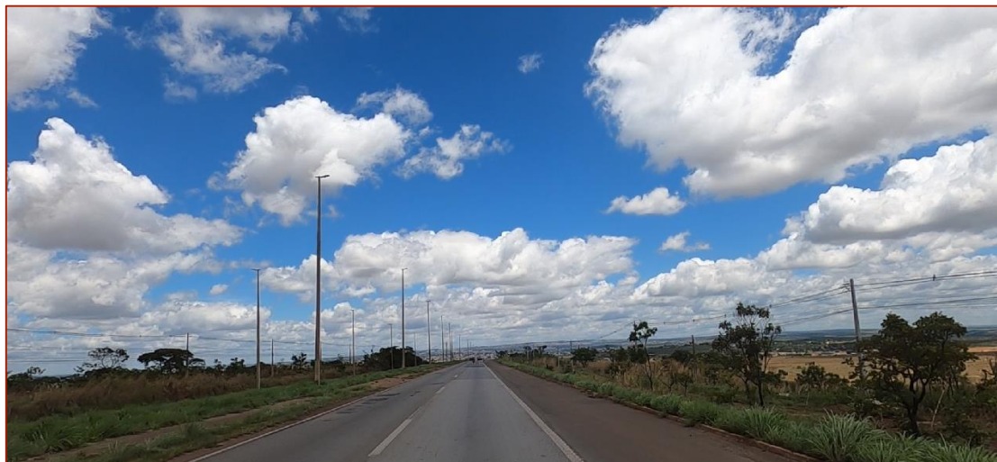
Figura 54 – Canteiros central e lateral reduzidos e com alto desnível
