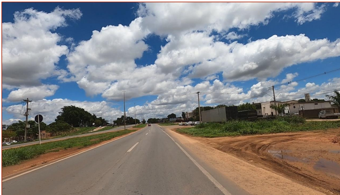
Figura 53 – Canteiros central e lateral reduzidos e com alto desnível
