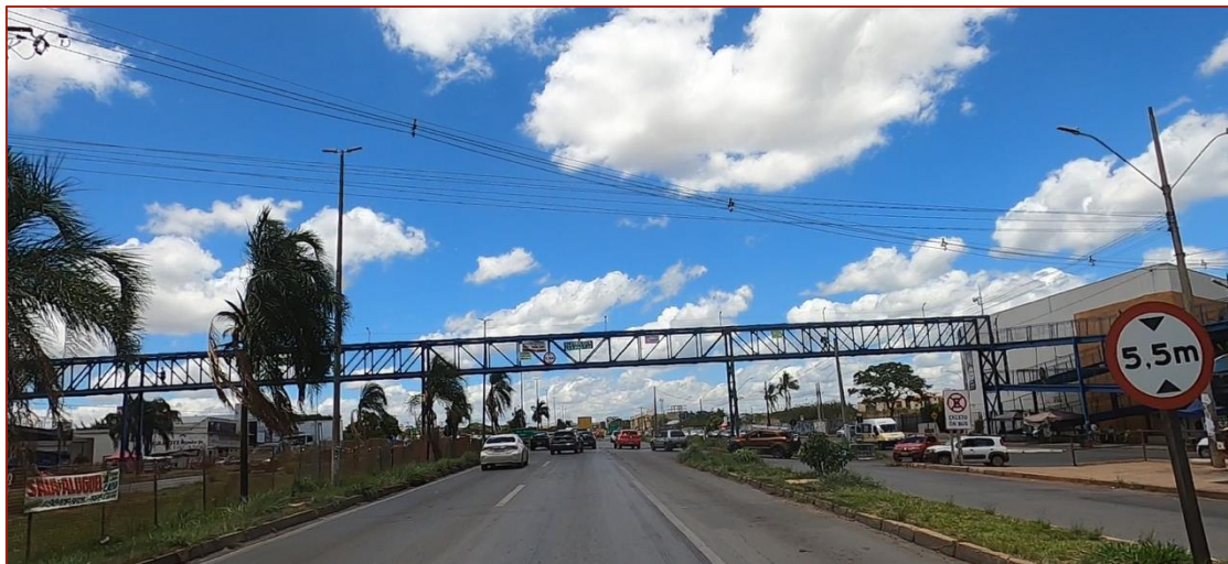
Figura 63 – Passarela de pedestres sobre a rodovia BR-040
