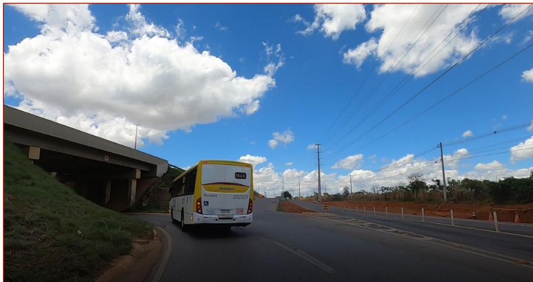
Figura 66 – Viaduto sentido Luziânia (GO)-Santa Maria (DF)
