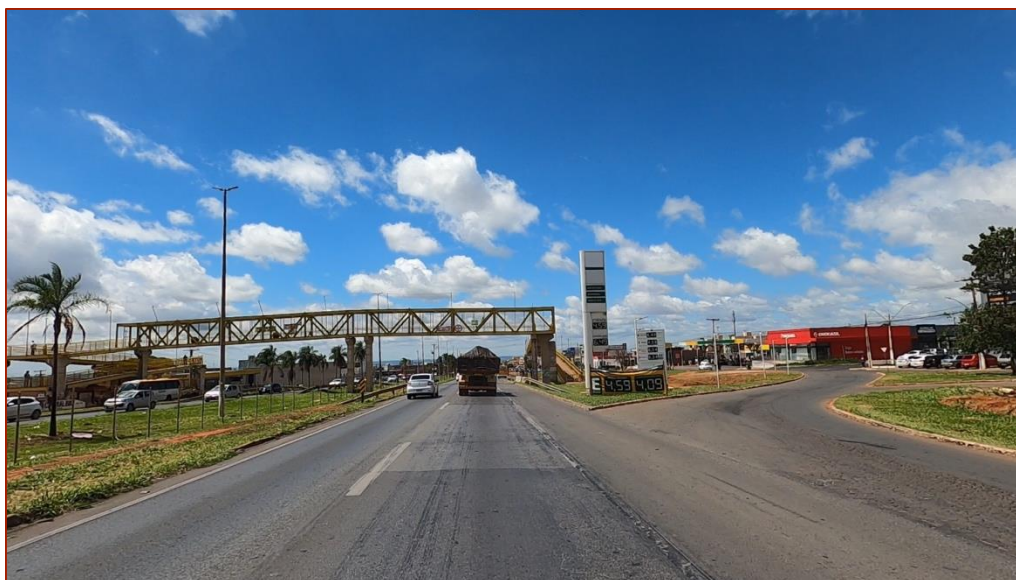
Figura 71 – Passarela sobre a rodovia
