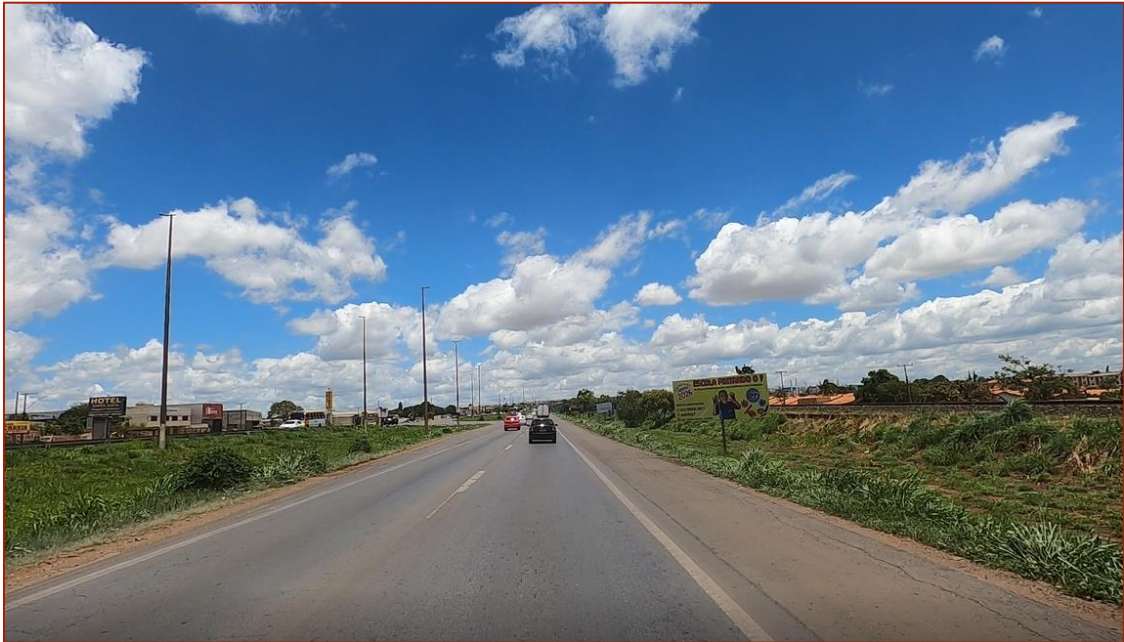
Figura 58 – Canteiro lateral com inclinação e passagem de ferrovia
