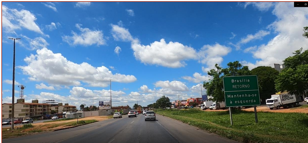
Figura 69 – Viaduto em construção no canteiro central
