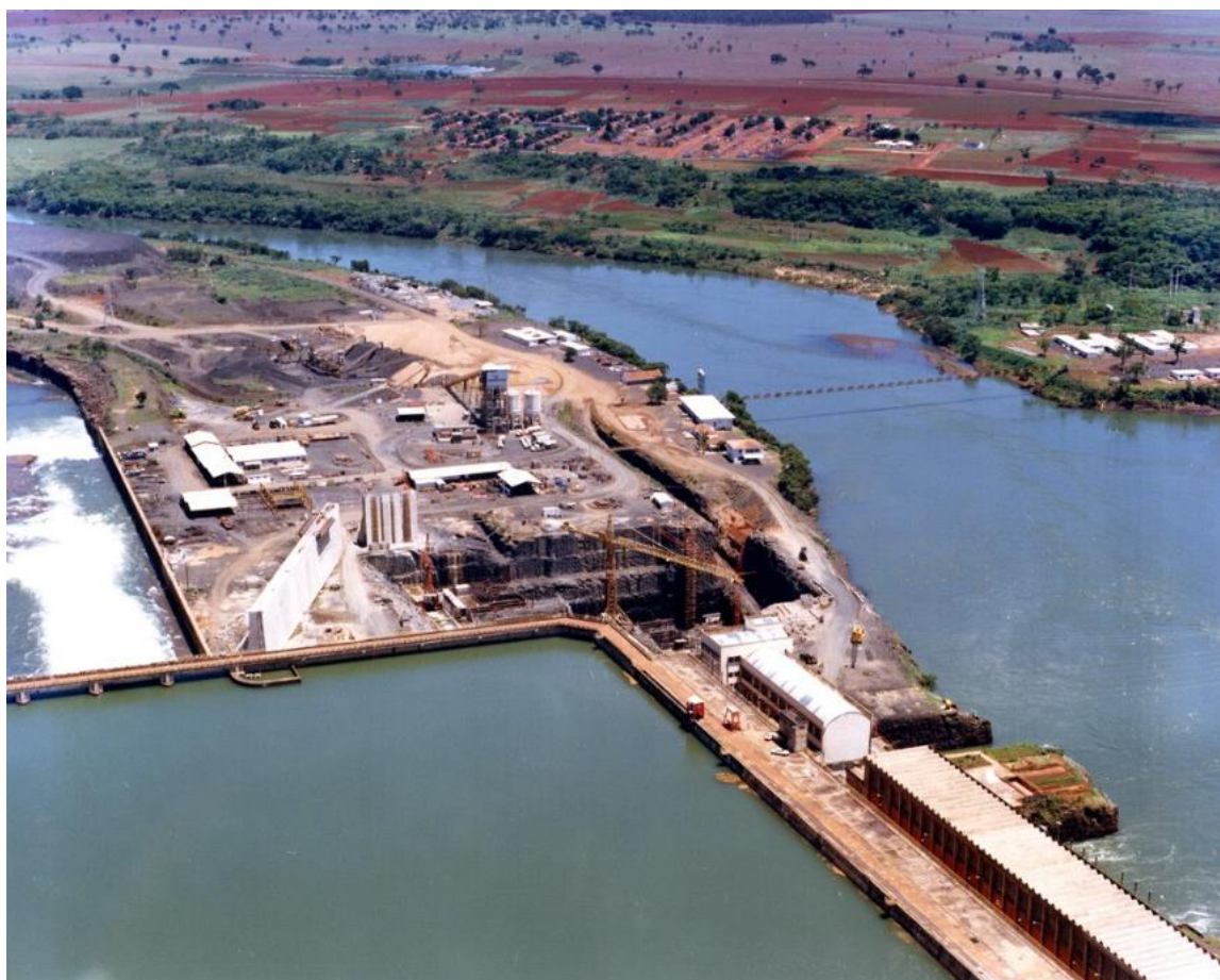
Figura 19 Visão panorâmica do canteiro de Obras da UHE Cachoeira Dourada
