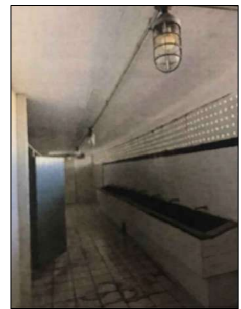
FOTO 1: VISTA DO BANHEIRO FEMININO, AOS FUNDOS ONDE SERÁ O SANITÁRIO FAMILIA.
