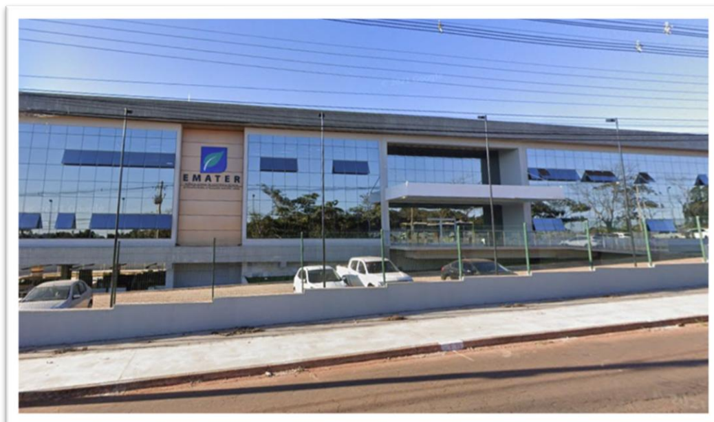
Imagem1 – foto da nova sede da Emater
