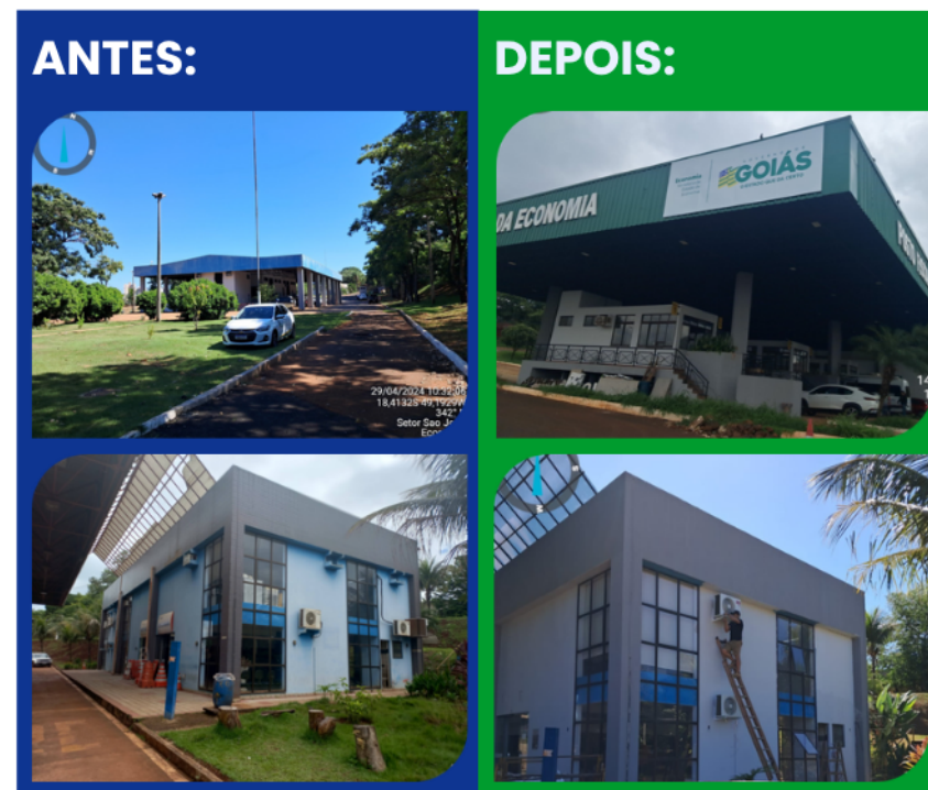
Figura 24 - Reforma do Posto Fiscal JK - Itumbiara
