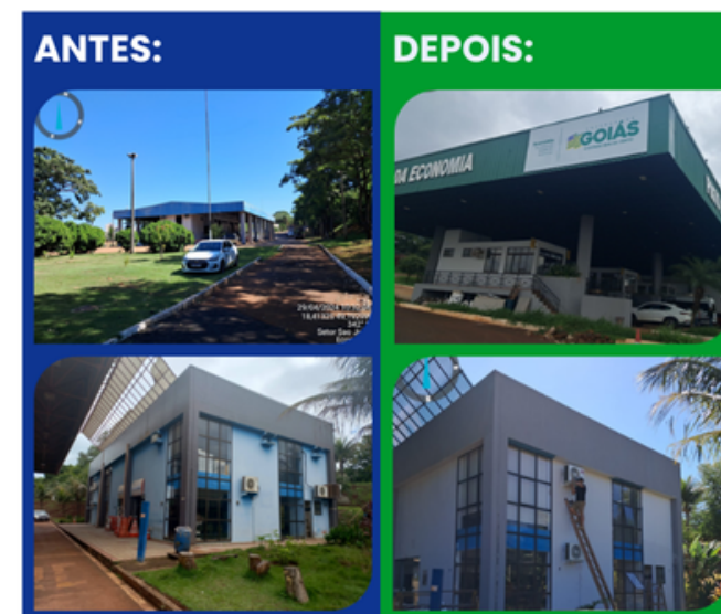
Reforma do Posto Fiscal JK - Itumbiara
