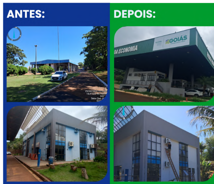
Figura 24 - Reforma do Posto Fiscal JK - Itumbiara
