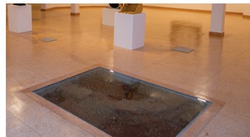
Janela de prospecção no salão expositivo permite visualização da escada original do edifício.
