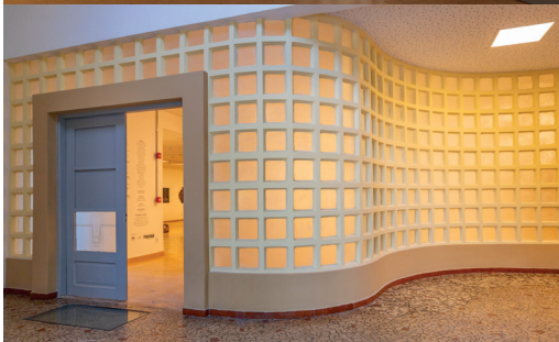
Tijolos de vidro anteriormente cobertos de tinta é recuperado, trazendo transparência e ampliação da luz no hall
