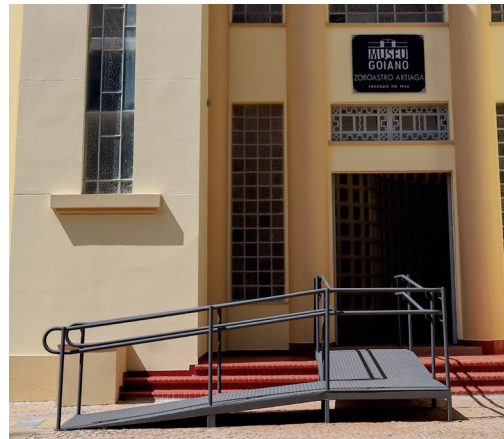
Rampa de entrada reforça acessibilidade universal ao ser inserida na fachada principal do edifício.
