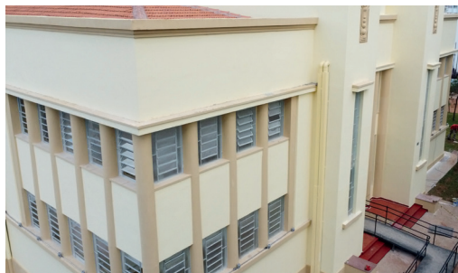
Intervenção preserva e evidencia a identidade Art Déco do edifício.
