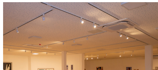
Modernização elétrica e luminotécnica atualiza o ambiente expositivo.
