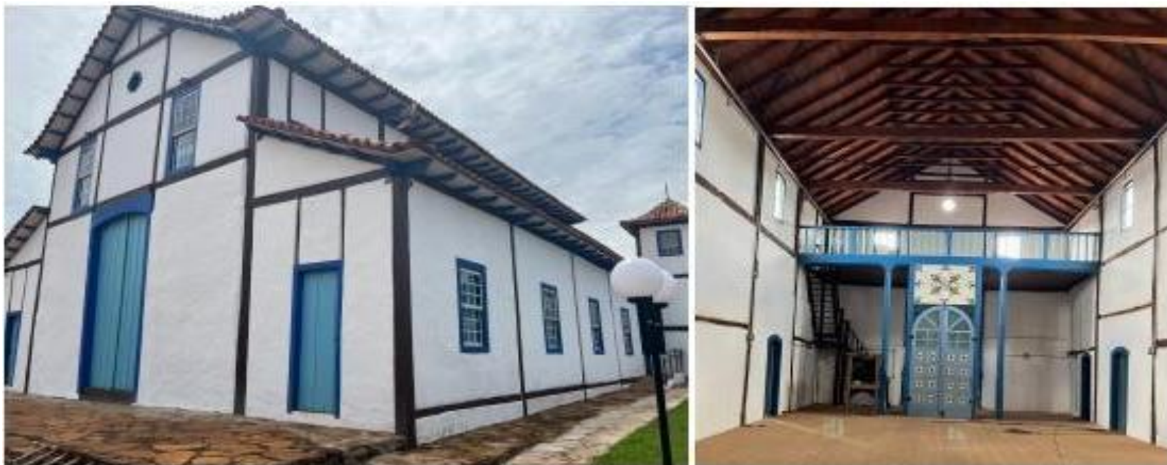
Figuras 08 e 09: Fachada e parte interna da Igreja de Nosso Senhor do Bonfim, devidamente restauradas
