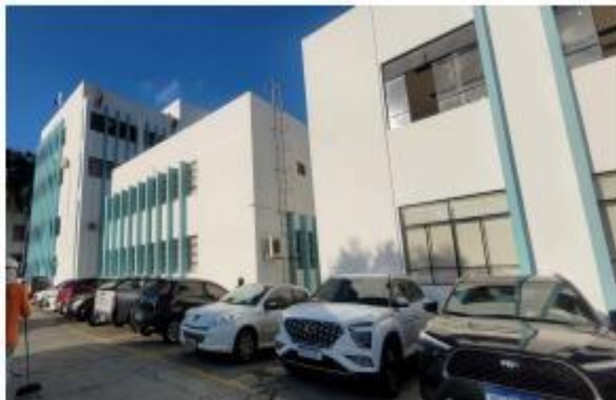
Figuras 06 e 07: fachadas devidamente restauradas
