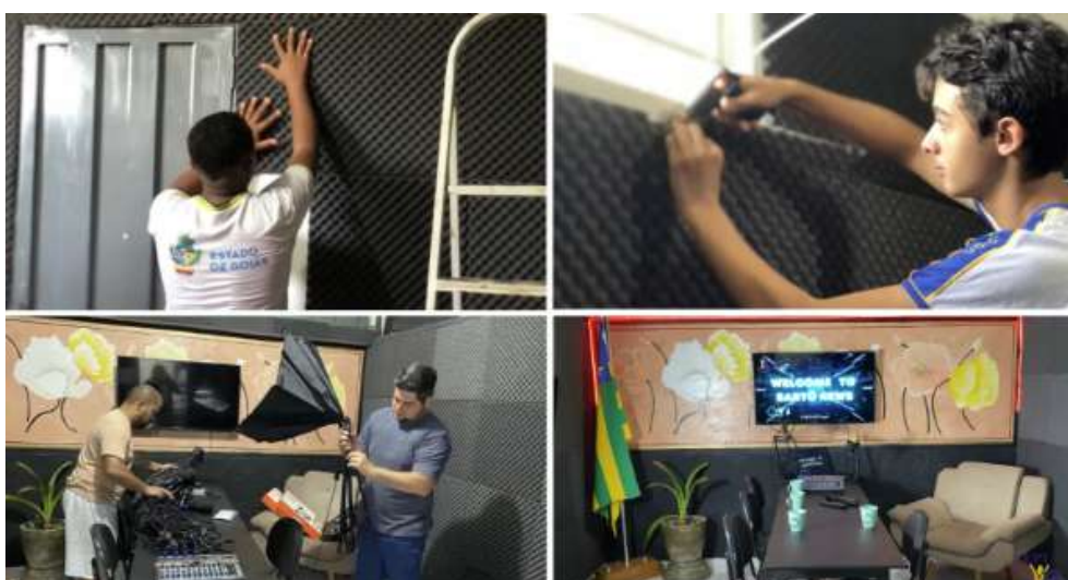
Imagem 4 - Processo de construção do estúdio de gravação realizado pelo Cepi Bartolomeu Bueno da Silva.
